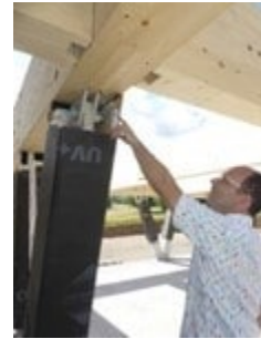
Abbildung 9: Stützenanschluss Träger © Wulf Architekten
