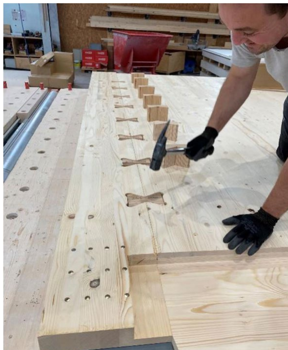
Abbildung 27: Holz-Holz-Verbindungen mit gefrästen Nocken, © Pirmin Jung Schweiz AG
