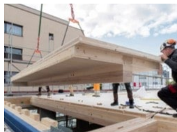
Abbildung 11: Montage Deckenelement © Pirmin Jung Schweiz AG
