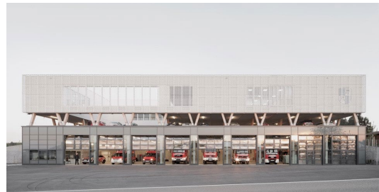
Feuerwehrhaus, Straubenhardt, 2022, Deutschland Bildquelle © Brigida González für Wulf Architekten
