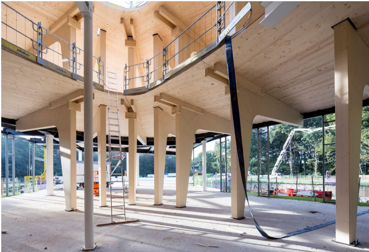
Abbildung 21: Montage tragendes Stützensystem aus Brettschichtholz mit Brettsperrholzdecken, © Carel van Hees
