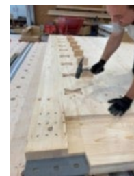
Abbildung 12: Steckverbindung Brettsperrholz © Pirmin Jung Schweiz AG
