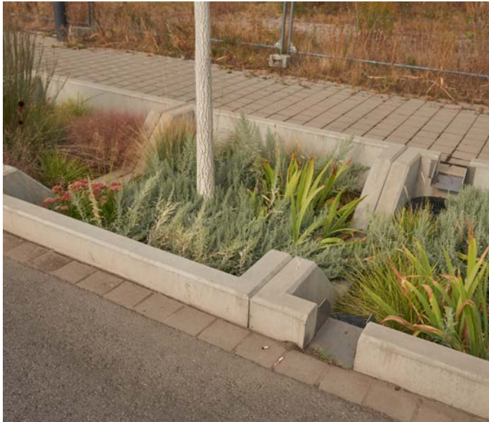
Foto: Hergen Schimpf Tiefbeete halten das Regenwasser zurück und versorgen die Pflanzen
