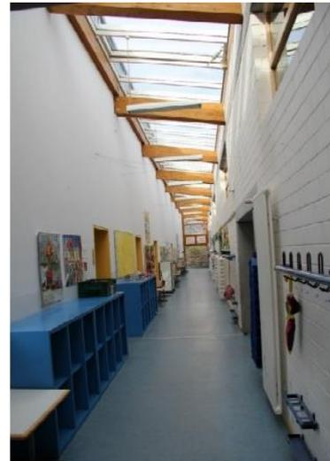
Abb. 35: Korridor: Belichtung über Glasdach (Foto: Institut Entwerfen und Bautechnik, FG Tragkonstruktionen, KIT).
