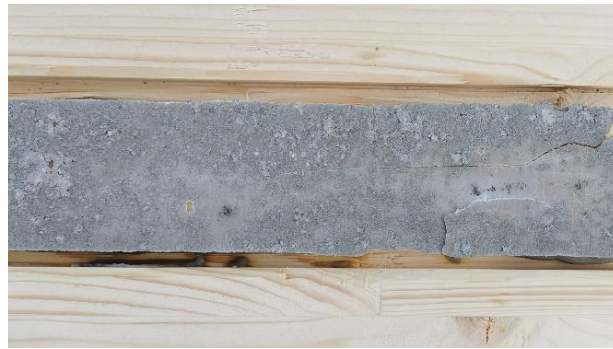
Abbildung 41 Oberflächennahes Fügeiteilveragen im Beton mit Anteilen von Adhäsionsversagen (am Beispiel einer Probe aus Serie SBB-TK-C3-FP)
