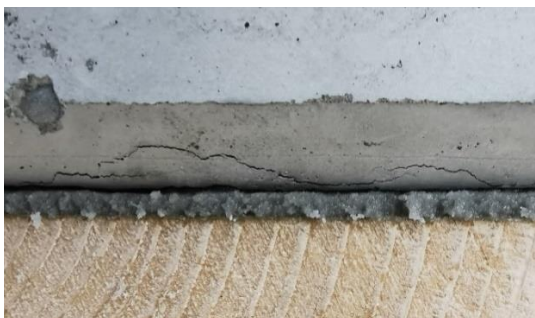
Abbildung 44 Risse im Beton an den Probekörpern der Serie B-TK-C3-FG
