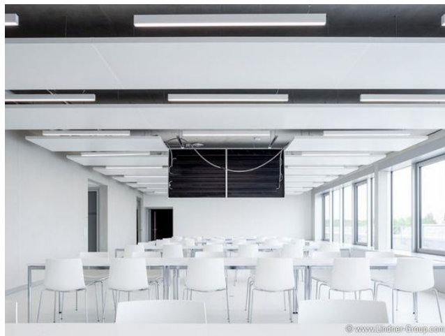
Abbildung 82 Heiz-/ Kühldeckensegel Plafotherm DS320 von Lindner mit einem zur Wartung heruntergeklapptem Panel [64]
