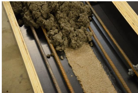
Abbildung 33 Betonage bei der Nassklebung (hier SBB-NK-E3)
