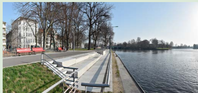
Foto: bgmr Treppenanlage Haveluferweg Altstadt Spandau
