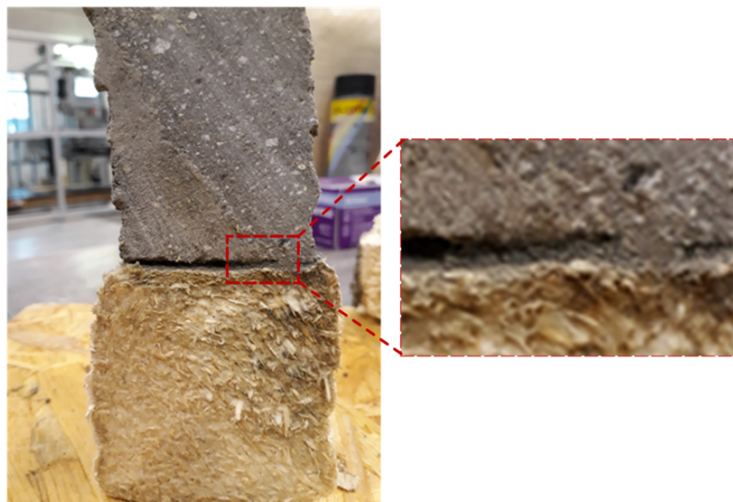
Abbildung 79: Kontaktbereich des Stützmaterials mit darauf 3D-gedrucktem Beton (Schnitt durch den erhärteten Festkörper).
