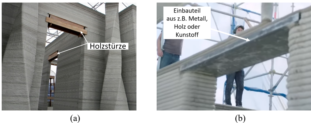
Abbildung 1: Beispiele aus der Praxis für die Herstellung der Überhangsstrukturen: (a) 3D-gedrucktes Hotel, Totalcustom, USA [3]; (b) 3D-Betondruck eines Wohnhauses bei Icon, Mexiko [4].
