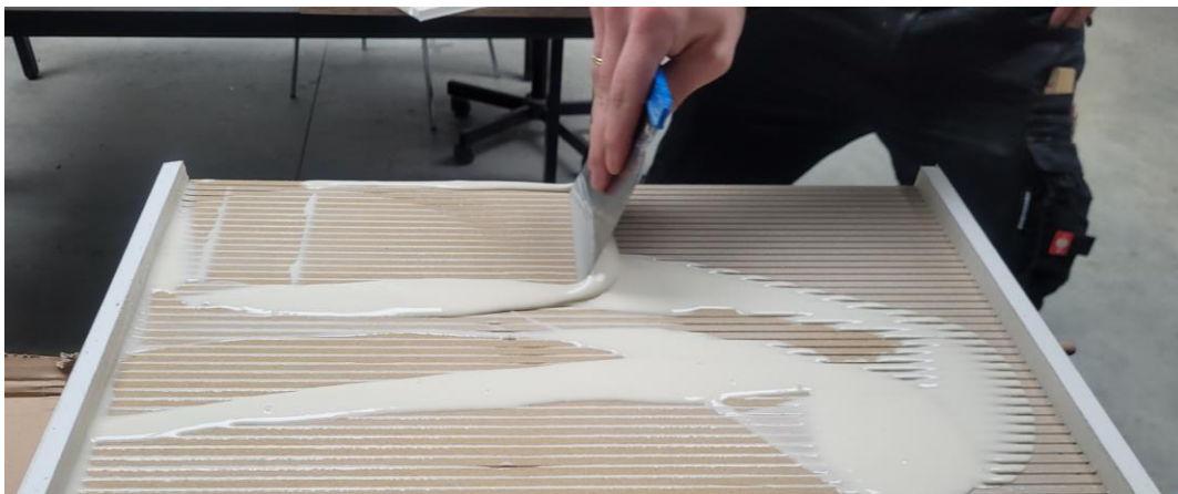
Abbildung 26: Applikation des Schaums per Spachtelauftrag auf eine geschlitze Gipskartonplatte.
