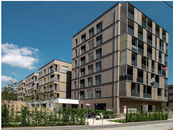
Abb. 2.20: Holzbausiedlung mit mehr als 500 WE. Foto: J. Hartl
