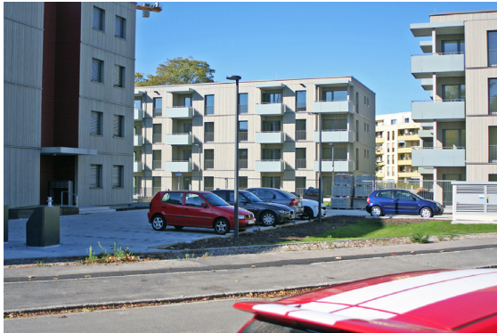
Abb. 2.9: Fassade aus Lärchenholz.
