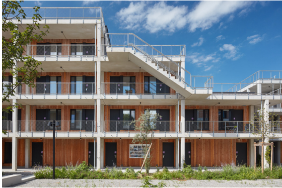
Abb. 2.17: Studenten-Quartier in Holzhybrid-Bauweise. Foto: S. Steinprinz
