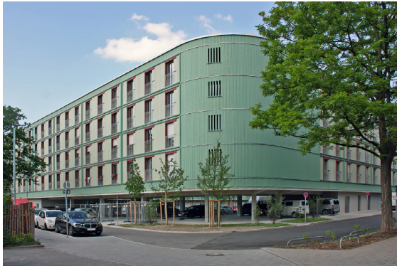
Abb. 2.18: Dante 2 über Bestandsparkplatz. Foto: J. Hartl
