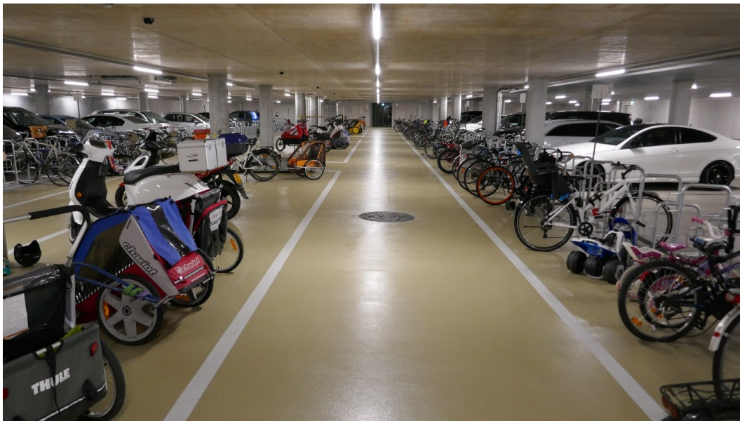
Abbildung 37: Blick in die Einstellhalle mit Fahrrad- und Kfz-Stellplätzen
