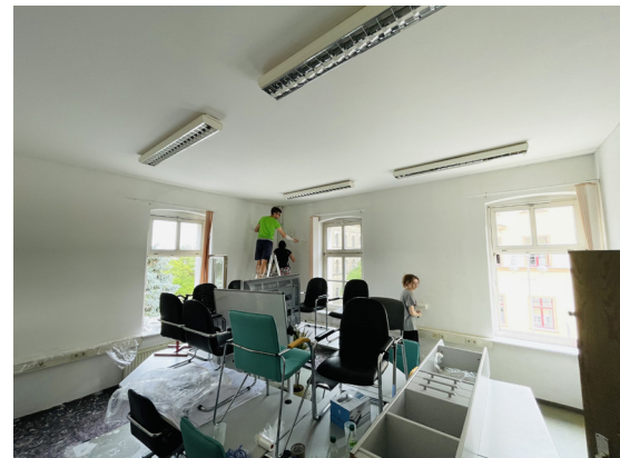
Tapezieren der neuen Räume
