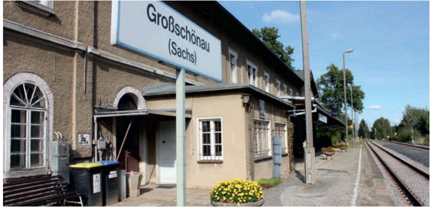
Eine multifunktionale Nutzung für den Bahnhof in Großschönau Foto: Hochschule Neubrandenburg
