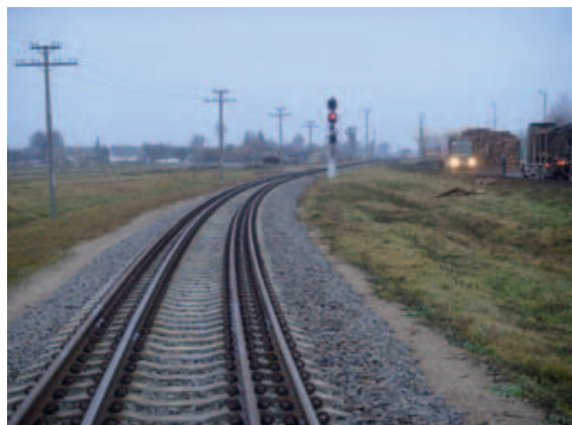
Modernisierter Streckenabschnitt mit russischer Breitspur und europäischer Normalspur nahe dem litauischen Grenzbahnhof Šestokai.
