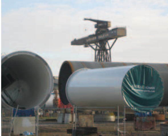
Montage von Offshore-Windanlagen auf ehemaligem Werftgelände
