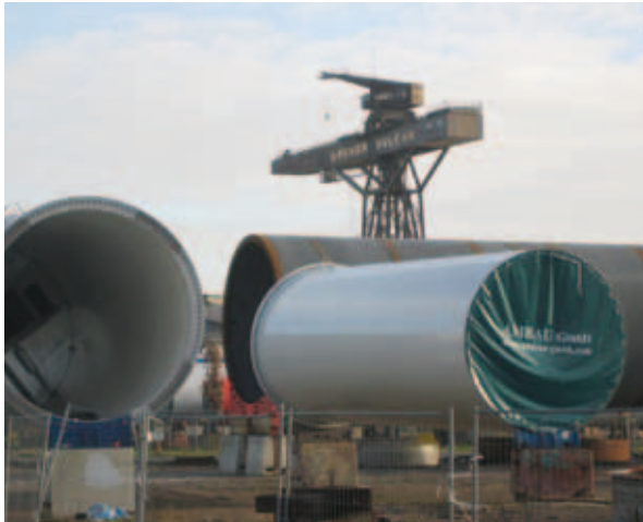
Montage von Offshore-Windanlagen auf ehemaligem Werftgelände
