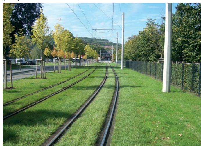
Stadtbahn auf attraktivem Rasengleis nahe einer Grünanlage (Gera)
