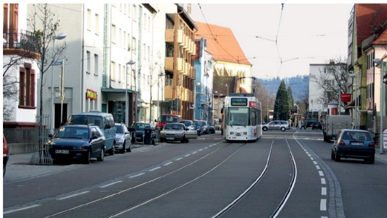
Straßenbündiger Gleiskörper im Stadtteilzentrum
