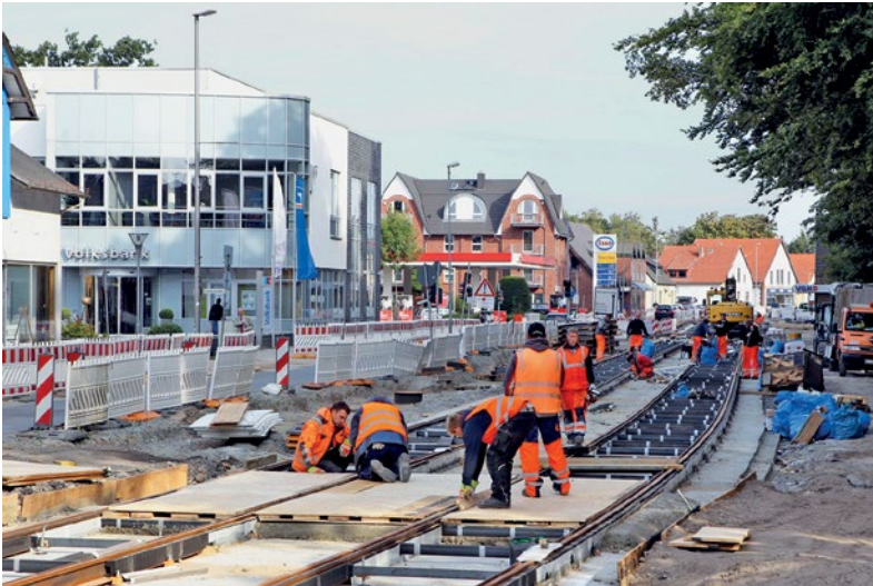
Verlängerung Linie 4 nach Lilienthal – hier die Bauarbeiten
