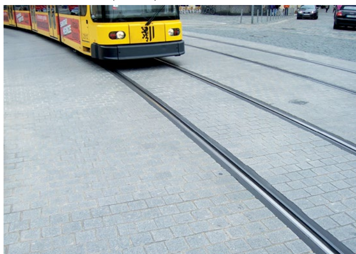
Gut gestaltetes und dauerstandfestes Pflastergleis in der Ausführung als „Pflastermonolith“ (Dresden)
