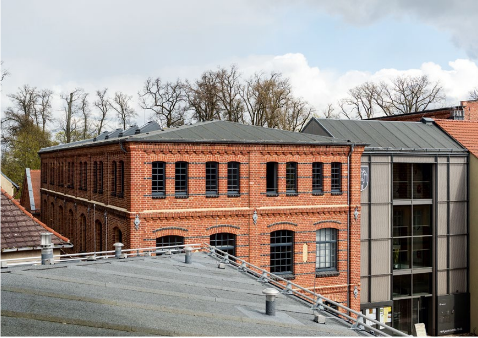
Wittstock/Dosse, Stadt- verwaltung, sanierter Altbau mit Neubau, 2017
