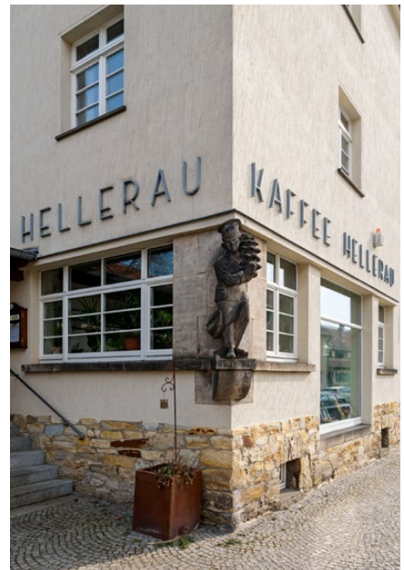
Gartenstadt Hellerau, Fassadendetail, 2018
