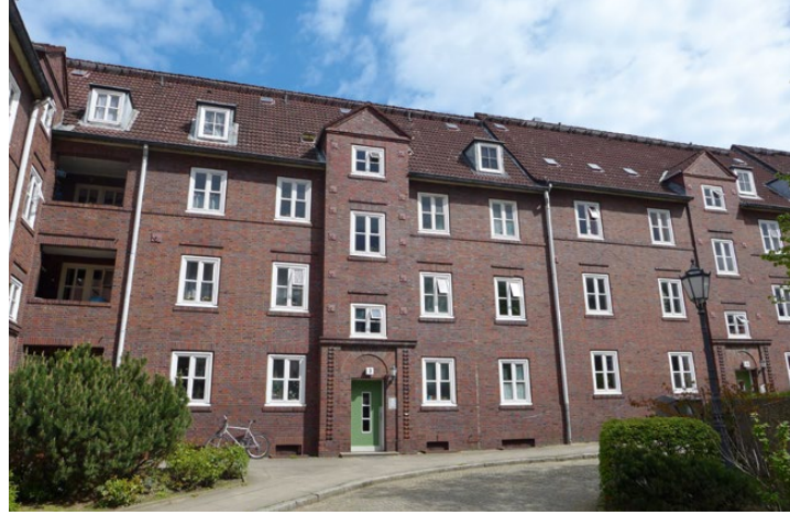
Hamburg-Dulsberg, Wohngebäude der Schiffszimmerer, öffentlicher Eingangshof, 2018
