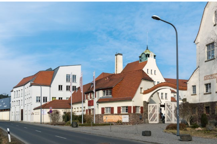
Gartenstadt Hellerau, Haupteingang zu den Werkstätten, links Neubau des Spänebunkers, 2018
