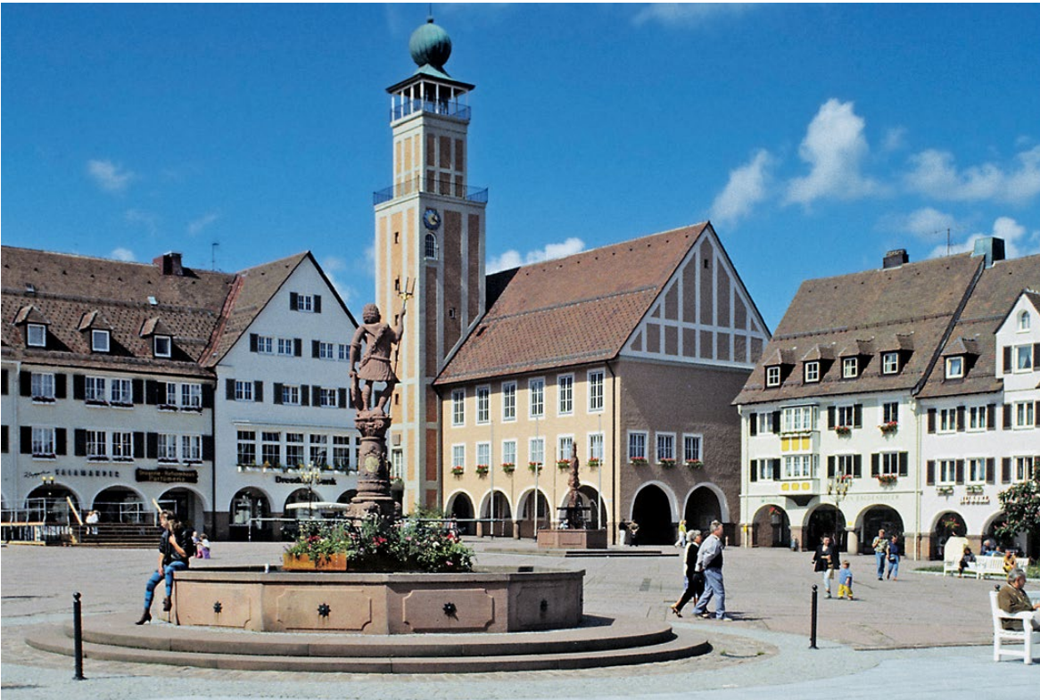
Freudenstadt, Häuser am Markt nach dem Wiederaufbau, Zustand 1998
