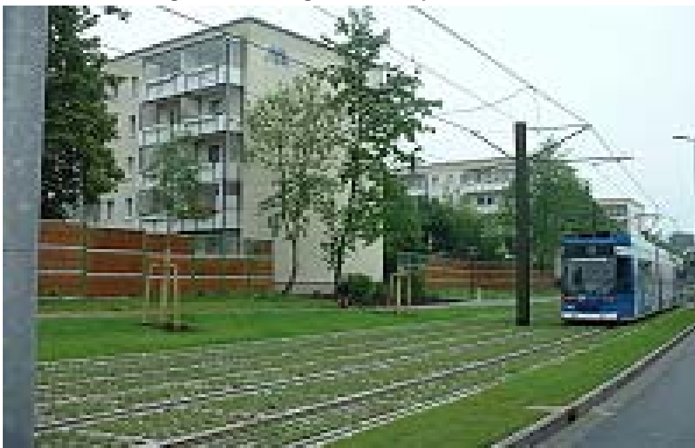
Abb. 8-16: Hofschließungen und Rasengleis am Beispiel der Nobelstraße
