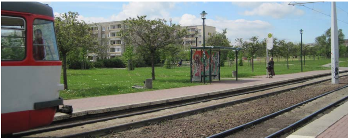
Abbildung 6: Rückbaubereich am Anhalter Platz in Halle/ Saale
