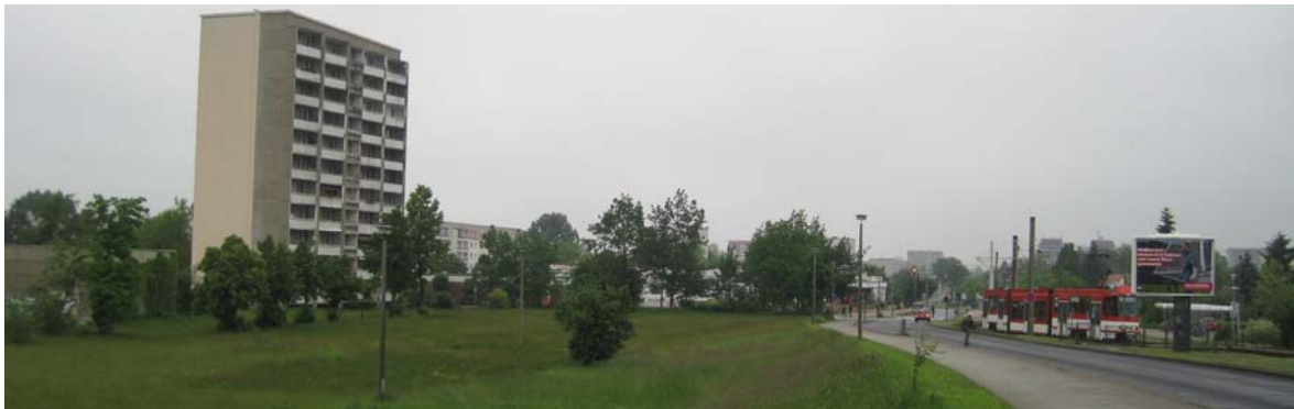
Abbildung 8: Rückbau in Cottbus-Sachsendorf im Straßenbahnnähe
