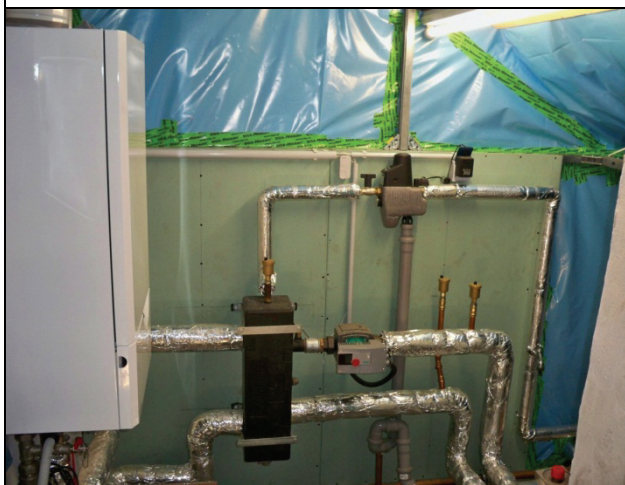
Gas-Brennwerttherme in separatem Aufstellraum im Dachboden
