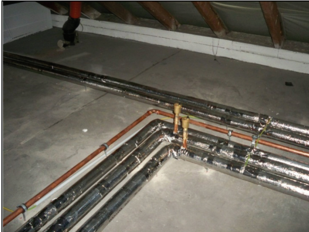
Verteilung auf dem Dachboden (oberste Geschossdecke wird nachträglich noch komplett wärmegeklämmt)
