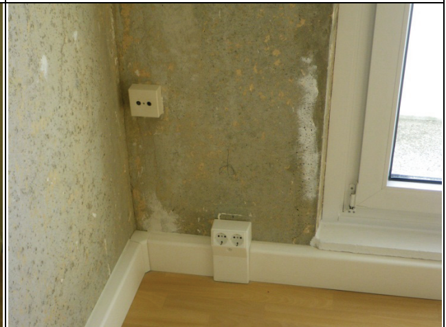
Horizontale Etagenverteilung in Sockelleiste in Verbindung mit Elektroinstallation
