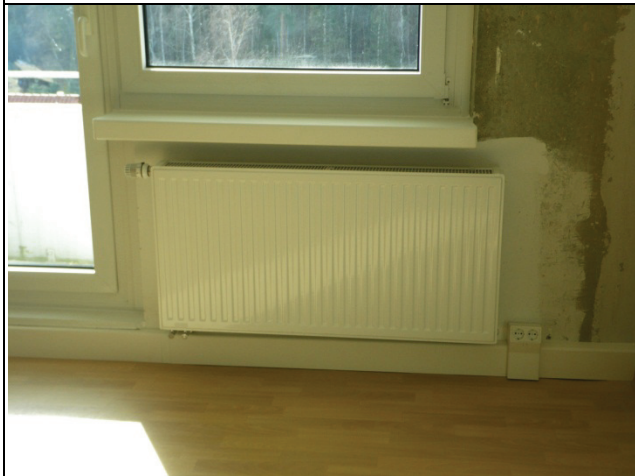
Horizontale Etagenverteilung in Sockelleiste in Verbindung mit Elektroinstallation
