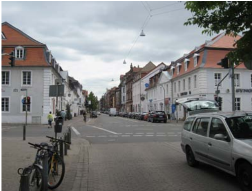
Mainzer Straße, Barockbebauung Quelle: empirica
