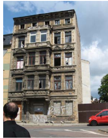
Baulücke an Ecke und weiterer Verfall von angrenzenden Gebäuden
