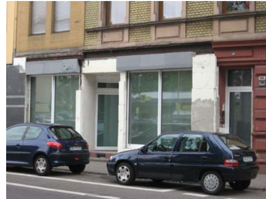
Mainzer Straße, Sanierungsstau Quelle: empirica
