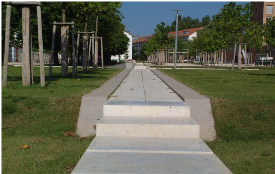
Abbildung 7: Entwässerungsrinne und Fußweg
