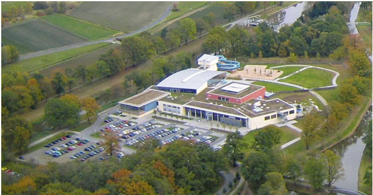
Abbildung 10: Beispiel Dachbegrünung auf Schwimmbad
