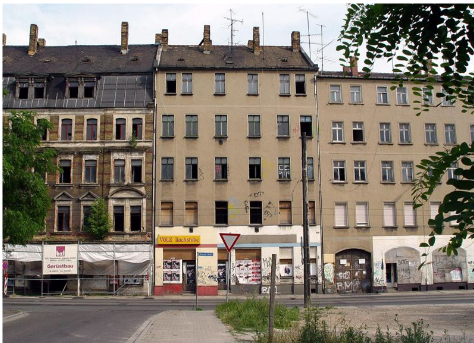
Abbildung 16: ehemalige Bebauung "Dunkler Wald"
