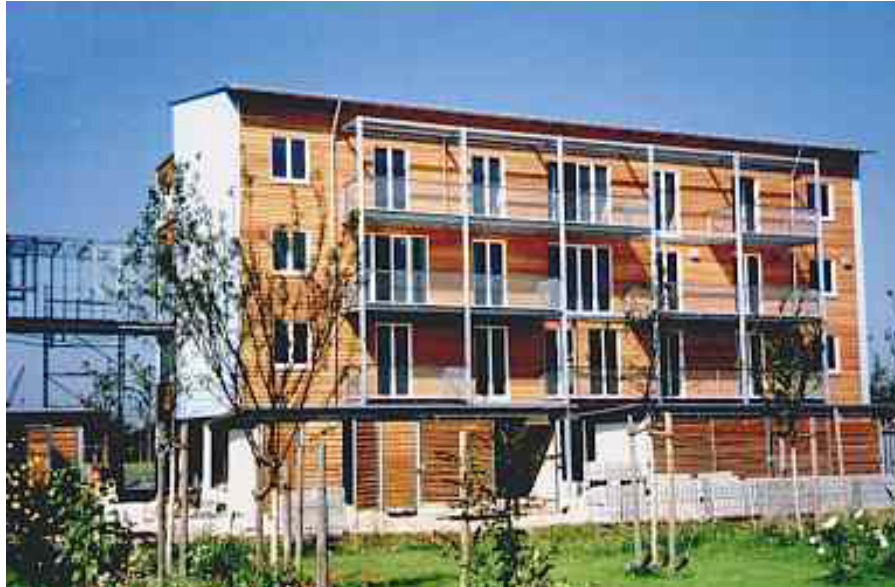
Abbildung 23: Gebäude WOGENO Vorderansicht
