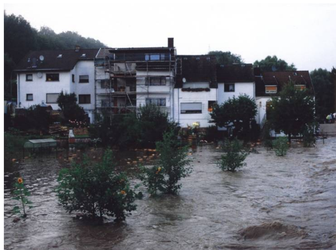
Abbildung 11: Überschwemmung in Rußhütte 2009
