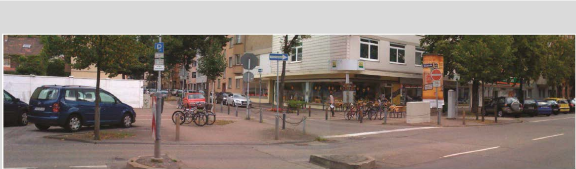
Mainzer Straße / Ecke Uhlandstraße (vorher) Quelle: Stadt Saarbrücken
