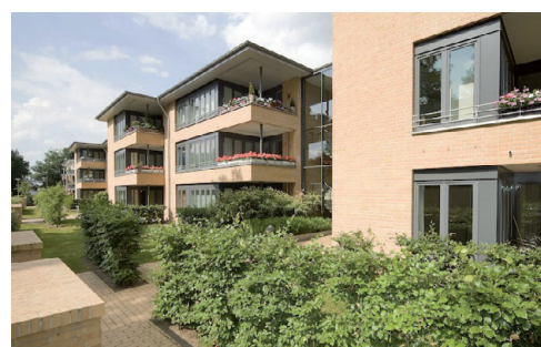
Foto: Trave Ersatzneubauten im Quartier „Brandenbaum“
