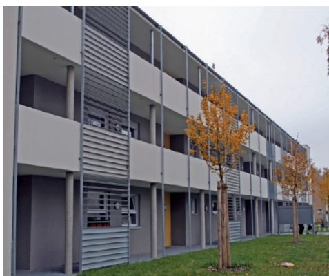
Foto: Arnt von Bodelschwingh Ersatzneubau in der Ingolstädter Straße
