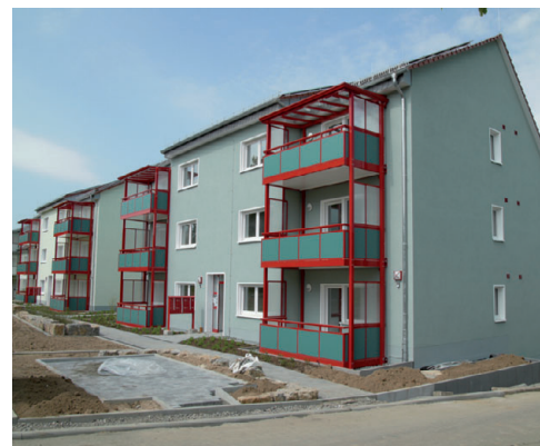
Foto: Baugenossenschaft 1894 Gießen eG Eingangsbereich der Ersatzneubauten
