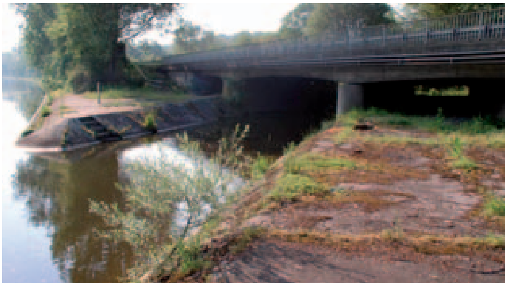
Im Mündungsbereich der Körsh sind sogar die Uferflächen betoniert
