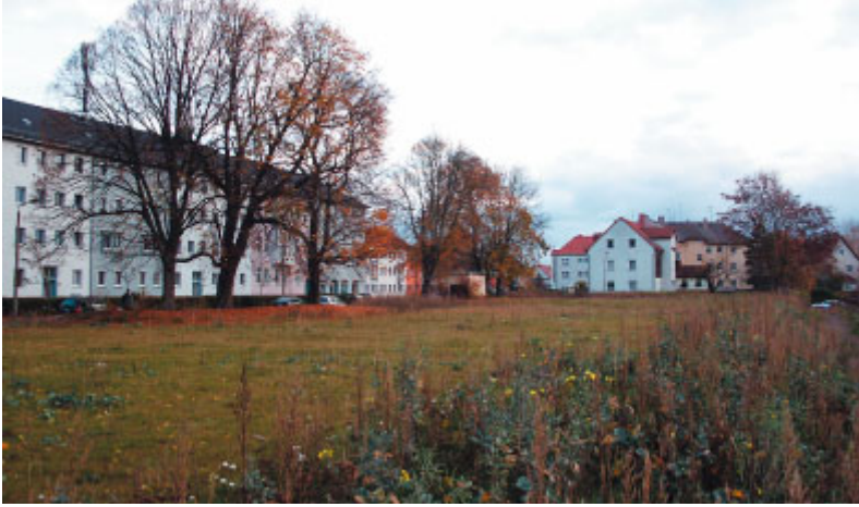
Abbildung 25: Freifläche nach Wohnungsrückbau in Nordhausen
