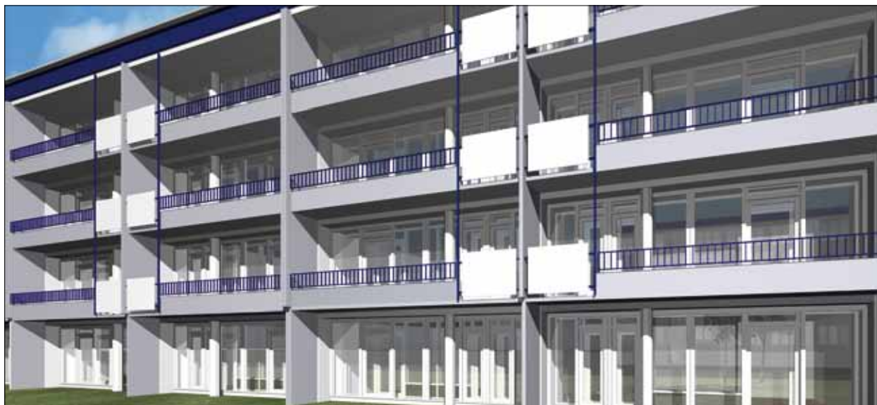
Fassaden der Wohnzeilen
