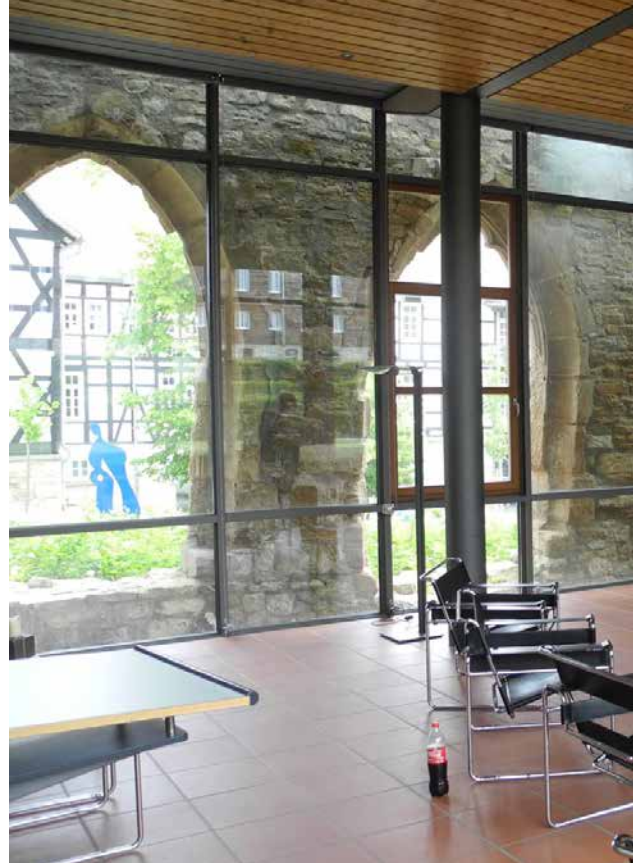
Beim Umbau des Konventgebäudes wurden Teile des Bestands erhalten und darüber ein Neubau in Stahlskelettbauweise mit großflächigen Verglasungen errichtet. Im Obergeschoß befinden sich einige Gästezimmer, eine Gemeinschaftsküche und eine Bibliothek, im Erdgeschoß gibt es mehrere Seminarräume. (Architektur: Planungsgruppe Stieldorf; Günther Hornschuh, Bernward Paulick)
