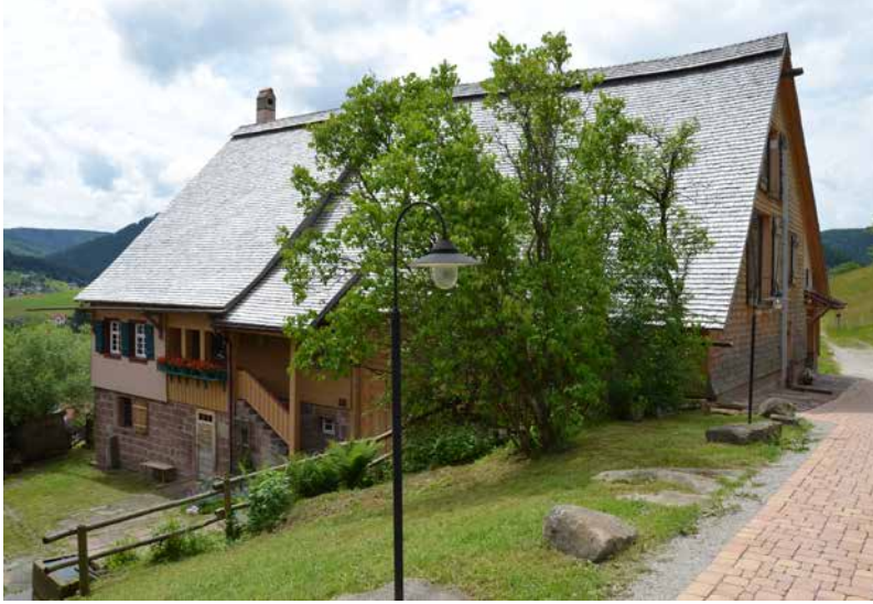
Der Morlokhof im oberen Murgtal ist einer der ältesten noch vollständig erhaltenen Bauernhöfe im Nordschwarzwald. Das ortsansässige Hotel Bareiss erwarb den Hof 2004 und führte anschließend eine durch das Landesdenkmalamt begleitete Sanierung durch. (Architektur: Architektin Sabine Rothfuß vom Büro Architektur con Terra)
