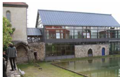
Beim Umbau des Konventgebäudes wurden Teile des Bestands erhalten und darüber ein Neubau in Stahlskelettbauweise mit großflächigen Verglasungen errichtet. Im Obergeschoß befinden sich einige Gästezimmer, eine Gemeinschaftsküche und eine Bibliothek, im Erdgeschoß gibt es mehrere Seminarräume. (Architektur: Planungsgruppe Stieldorf; Günther Hornschuh, Bernward Paulick)
