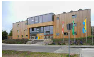
Die Kindertagesstätte „Burg“ vor und nach der Sanierung (Planung: Martin Wollensak mit Architekturbüro Holtz Gostomzyk)
