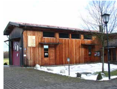
Das neue Gebäude der Freiwilligen Feuerwehr in Holzolling, das auch den örtlichen Schützenverein beherbergt, wurde 2004 fertiggestellt und unter Mitarbeit der Dorfgemeinschaft errichtet. Engagierte beteiligten sich mit über 6.000 ehrenamtlichen Stunden, wie auf der Homepage stolz berichtet wird. Der Baufortschritt wurde fotografisch dokumentiert und die Eröffnung mit einem großen Fest gefeiert.
