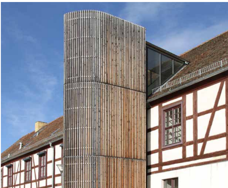
Liftzubau am historischen Gebäude Markt 11, das unter anderem das Luckenwalder Heimatmuseum 23 beherbergt. (Planung: Architekt Werner Jockey, Berlin; Ausstellungsgestaltung: Claudia Rücker und Andrea Szatmary)
