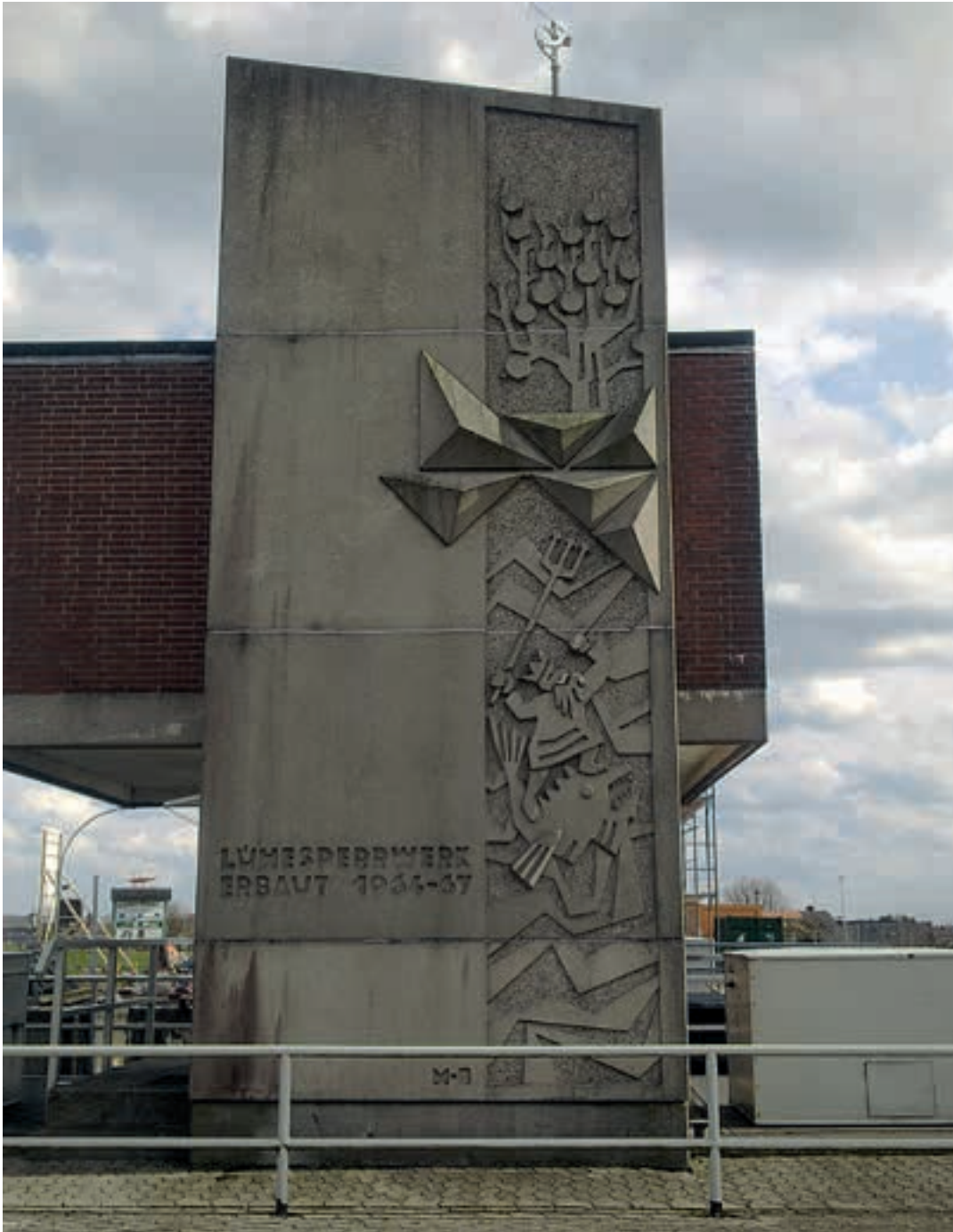
Lühe-Sperrwerk, Grünendeich, Sturmflutrelief aus Beton von Heinz Meyer-Bruck (1923–1997), 1967
