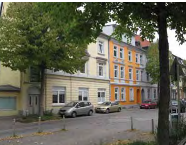
Foto: Bereits sanierte Häuserzeile
