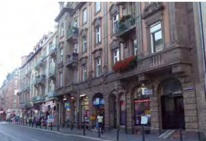
Foto: Gründerzeitliche Bebauung in der Mittelstraße
