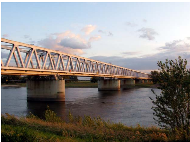
Eisenbahnbrücke über die Elbe bei Wittenberge
