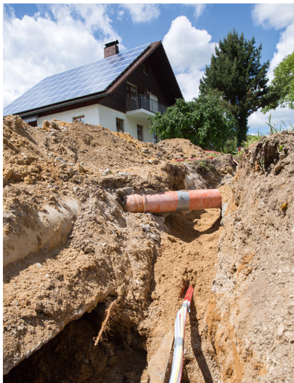
Bauarbeiten im Zweckverband Laber-Naab Quelle: atene KOM GmbH
