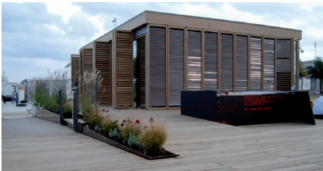
Abbildung 1: Nordwestecke des Gebäudes [Quelle: Leon Schmidt; TUD]
