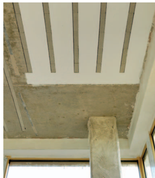
Abbildung 5: Detail der Geschossdecke mit eingeklebten Glasschaumstreifen
