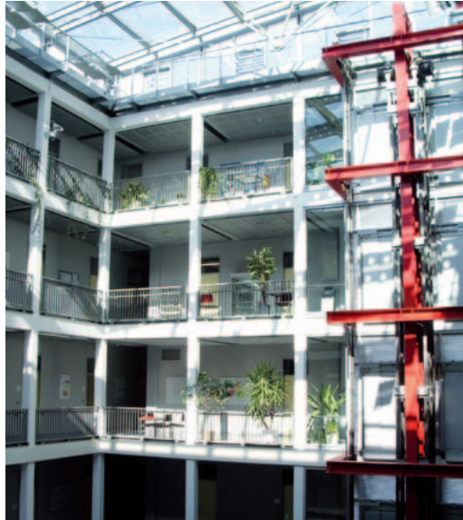
Abbildung 2: Informatikzentrum der TU-Braunschweig
