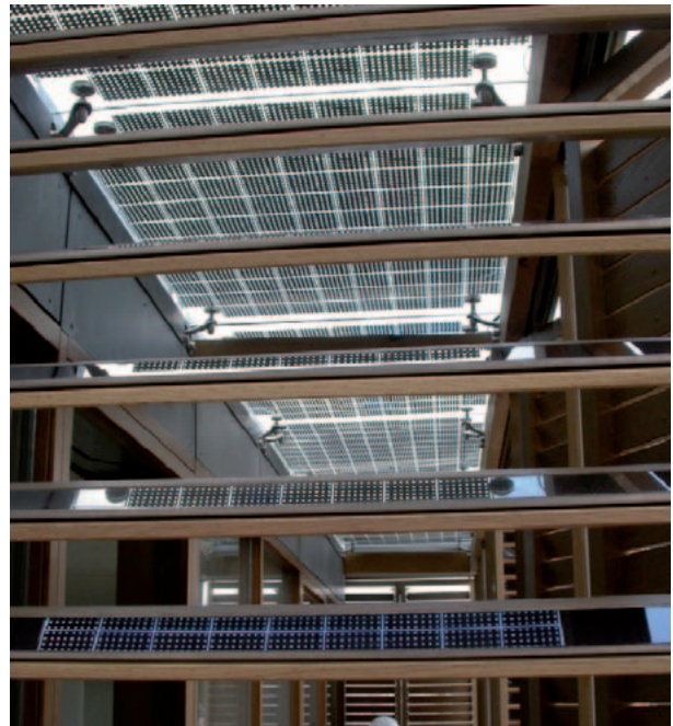
Abbildung 2: Solardach und Solarlamellen [Quelle: Simon Schetter; TUD]
