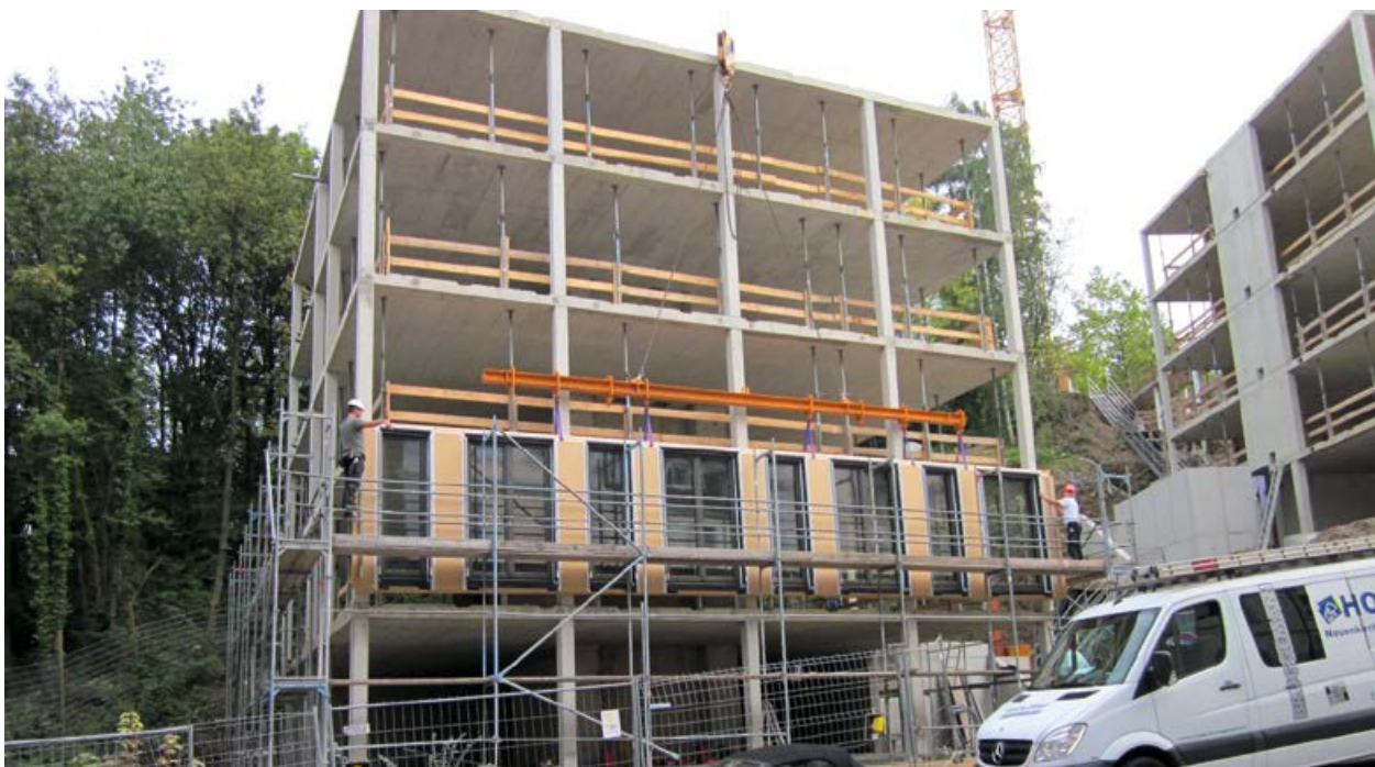
Abbildung 7: Montage vorgefertigter Holztafelelemente
