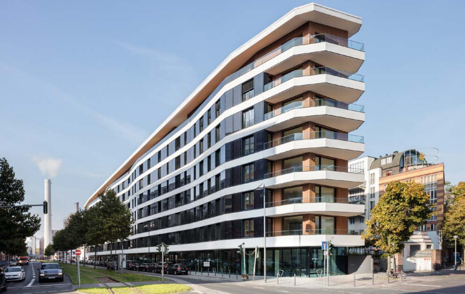
Das etwa 150 Meter lange und nur 10 Meter tiefe Das Aktiv-Stadthaus in Frankfurt ist mit 74 Mietwohneinheiten von 2- bis zu 4-Zimmer-Miet-Wohnungen errichtet worden. Mit Hilfe eines Touch Panels kann in jeder Wohnung der eigene Verbrauch jederzeit individuell hinterfragt werden.
