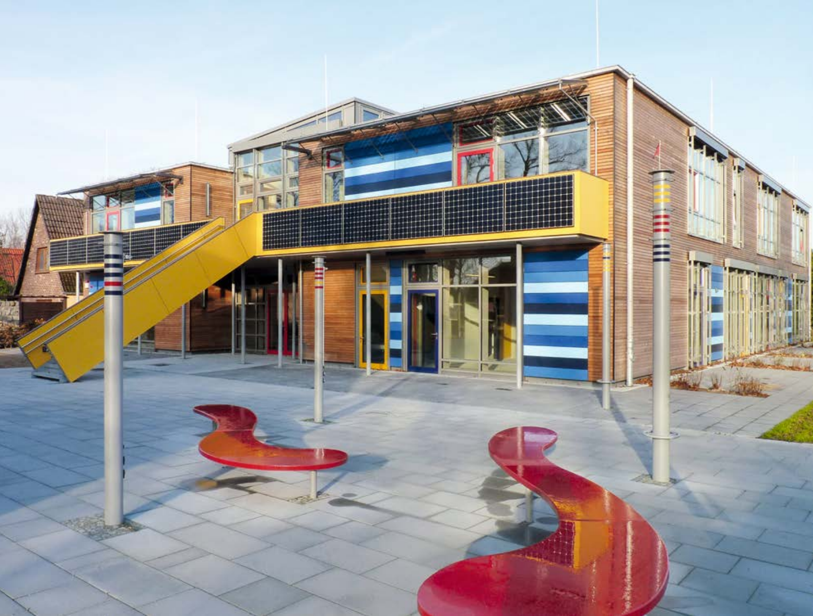
Die Kindertagesstätte in Wustrow erfüllt bereits die Anforderungen des Effizienzhaus Plus Standards.
