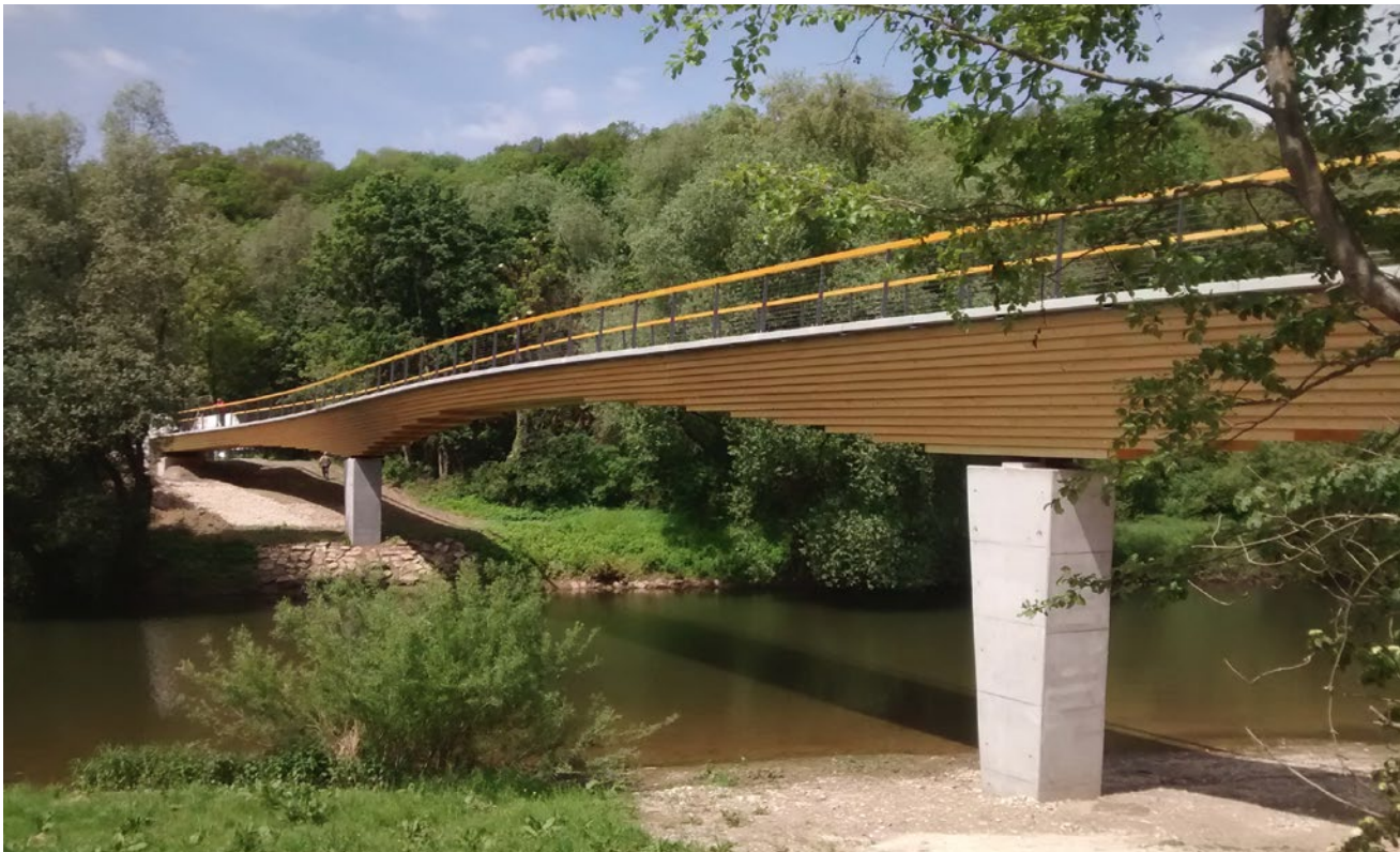
Abbildung 73: Ansicht der Brücke Neckartenzlingen mit montierten Sensorlamellen im Zwischenlagerbereich
