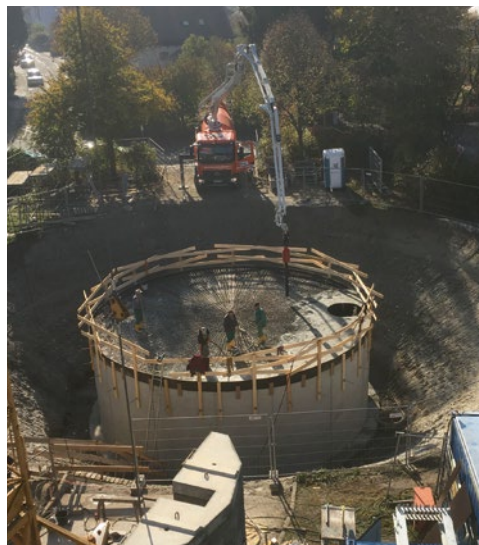
Abbildung 41: Der Eisspeicher des Berufsschulzentrums Mühldorf am Inn während des Betoniervorgangs.
