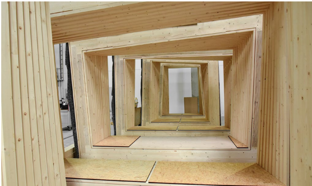
Abbildung 5: Alle vorgefertigten Gebäudesegmente sind bereit zum Aufbau vor Ort. „Just in sequence“ gefertigt.
