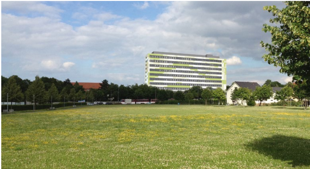
Abbildung 79: Die ehemalige Zahnklinik in Erfurt wird durch das Studierendenwerk Thüringen als Wohnhaus mit 251 Wohneinheiten umgebaut. Das zwölfgeschossige Gebäude in unmittelbarer Nähe zur Universität ist als Stützen-Riegel-System aus Stahlbeton konstruiert. Eine Modernisierung mit einem hohen Maß an Modularität und Vorfertigung von Elementen als Baukastensystem sind so möglich.
