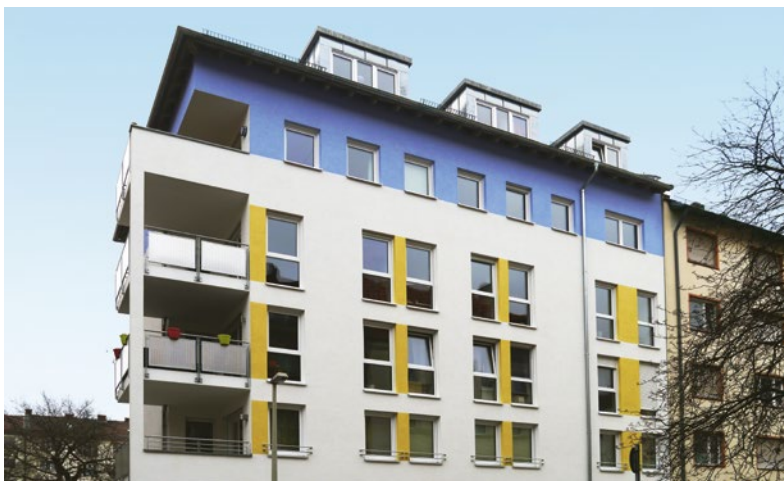
Abbildung 122: Neubau in günstigeren Lagen südlich der Altstadt, Nürnberg – St. Leonhard
