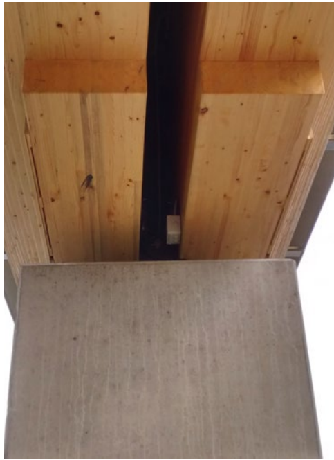
Abbildung 72: Nachrüstlösung der Sensorlamellen mit dünnen vorgesetzten Lamellen
