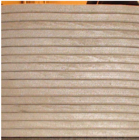
Abbildung 95: Ausschnitt einer gedruckten Beton-Wand (oben)
