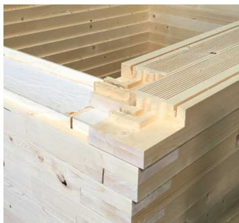
Abbildung 7: Liegender Aufbau von insgesamt sechs Gebäudesegmenten, die jeweils ungefähr 1 m lang waren. Zwischen den Lagen wird Leinenstoff zur Abdichtung verwendet.
