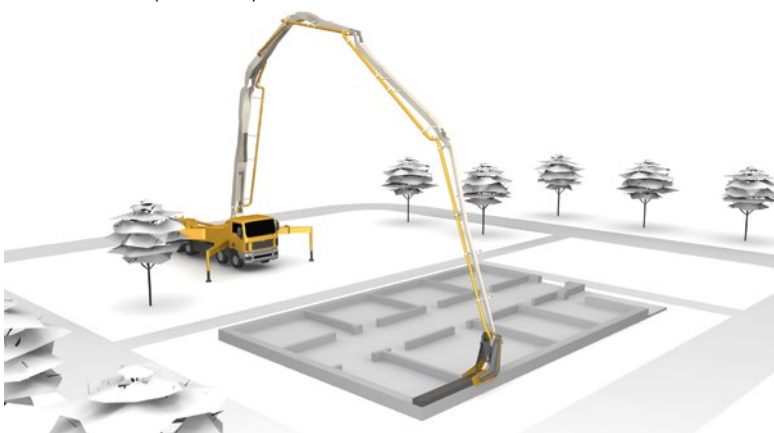
Abbildung 93: Beton-3-D-Druck direkt auf der Baustelle (Animation)
