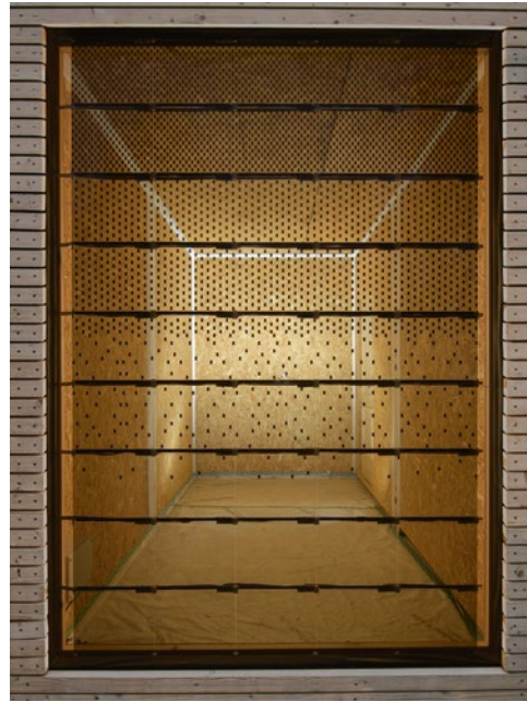
Abbildung 62: Raumhohe Isolierverglasung mit 45 integrierten TN-Modulen. Grafikdarstellung auf der TN-Ver- glasung (Holzschnitt „Sky and Water I“ von M. C. Escher). Blickrichtung von außen in den Raum (ganz links).
