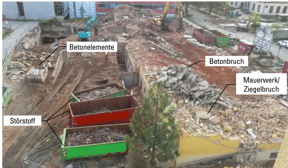
Abbildung 101: Abbruchbaustelle mit vorsortiertem Bauschutt
