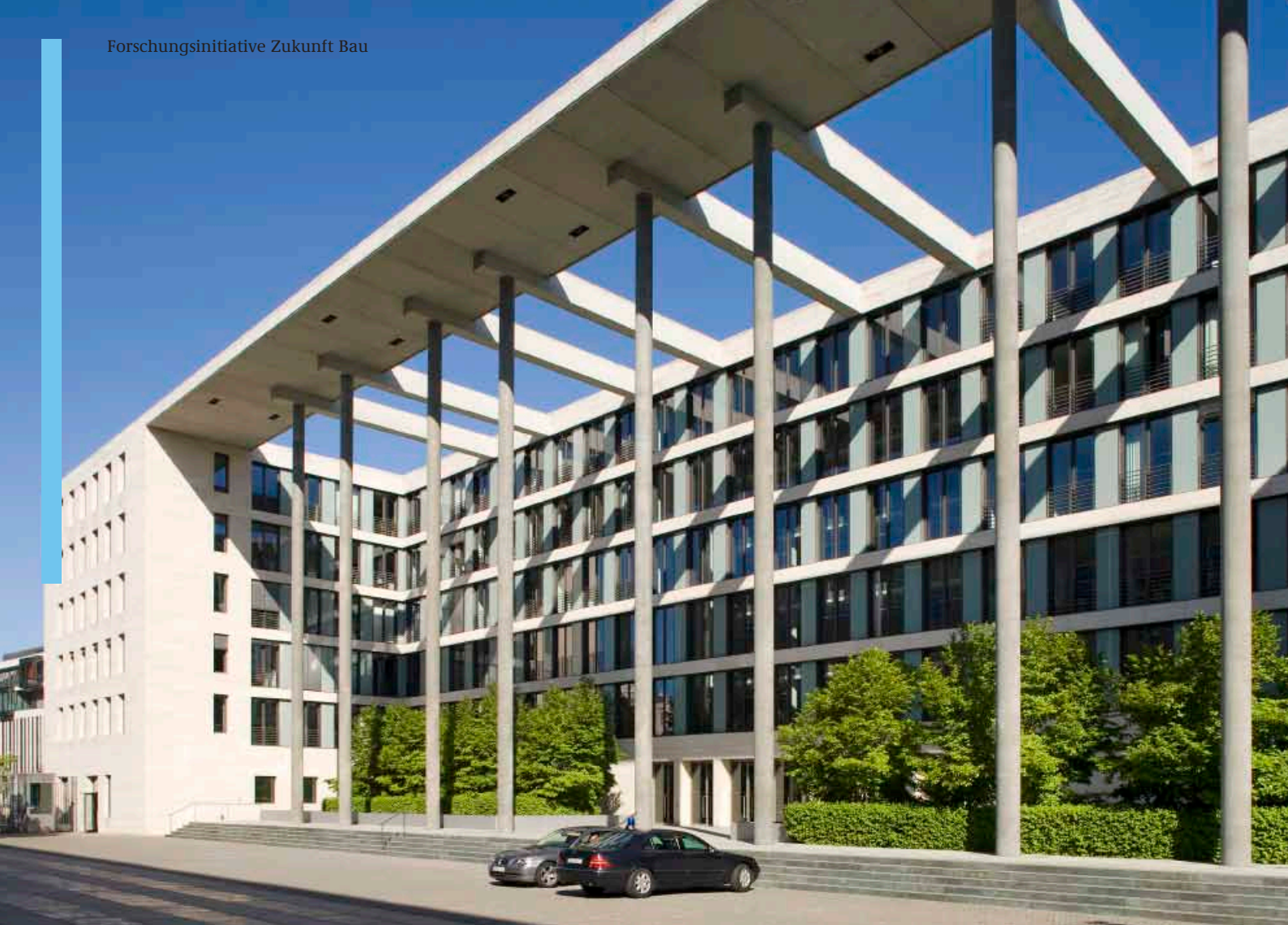
Neubau des Auswärtigen Amtes Architekten Thomas Müller und Ivan Reimann Foto: Bundesamt für Bauwesen und Raumordnung
