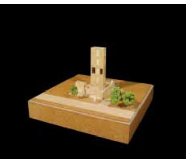
Modell: Das aussteifendes Massiv-Treppenhaus bildet das Rückgrat der Konstruktion,...
