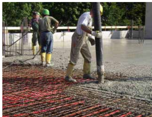
Betonieren einer Geschossdecke mit Rohrleitungen (rot) für die Bauteilaktivierung, Foto: Hochschule Offenburg
