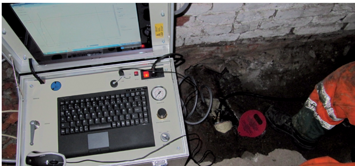
Druckverlustmessung bei der Dichtheitsprüfung mit Luftdruck
