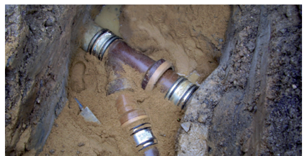
Reparatur einer Leitung in offener Baugrube
