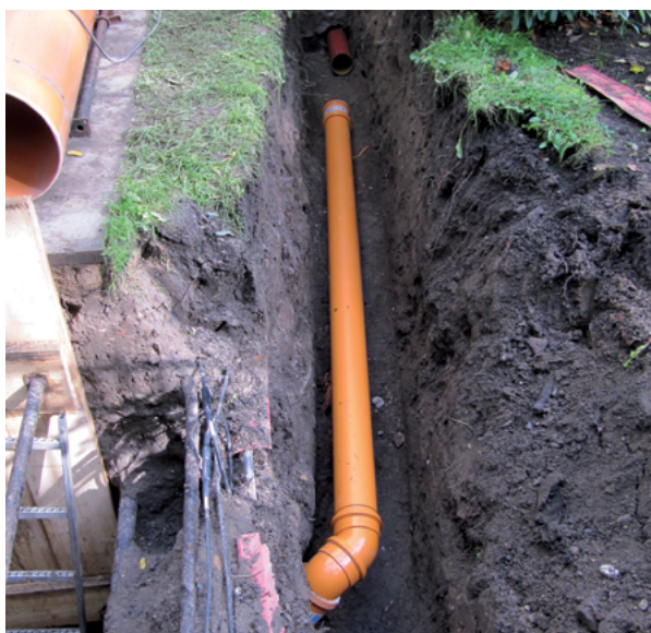
Erneuerung einer Abwasserleitung
