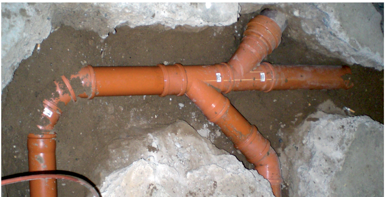
Aufwändige Erneuerung von Abwasserleitungen unter der Bodenplatte
