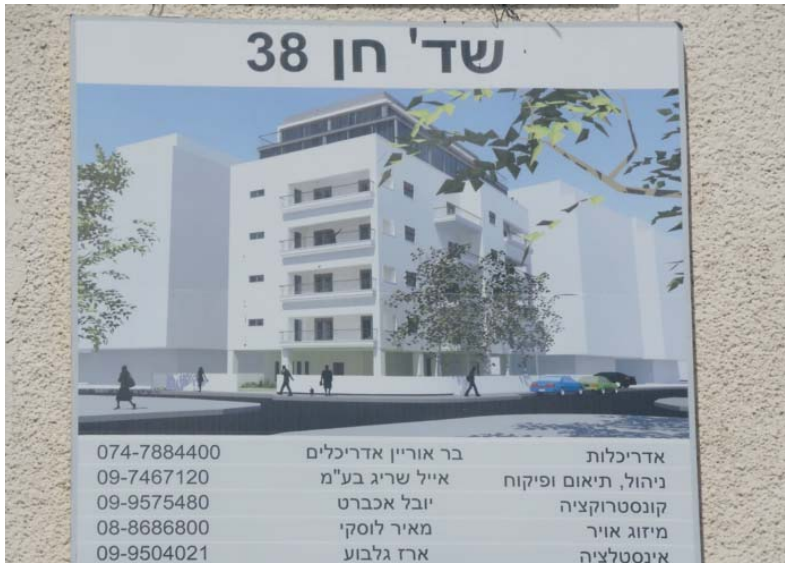
Abbildung 92: geplanter Ausbau (Quelle: Baustellenschild) mit zwei zusätzlichen Dachgeschossen und deutlicher Vergrößerung der Kubatur (vgl. Abbildung 91 oben), Sderot Hen Street 38, Tel Aviv, 2013
