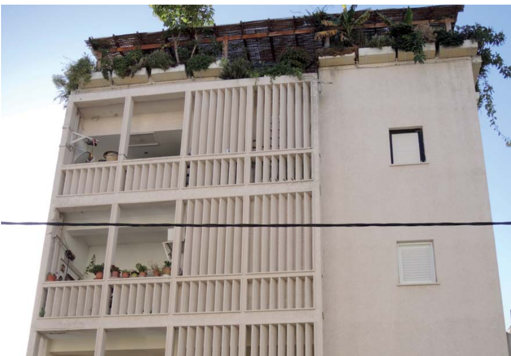
Abbildung 47: Vertikallamellen zum Einfangen des Seewinds und zur Verschattung, Tel Aviv, 2013
