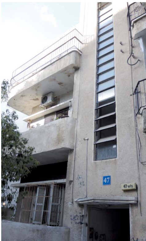
Abbildung 76: „Thermometer“-Fenster mit Stahlrahmen und beweglichen Scheiben, Tel Aviv, 2013
