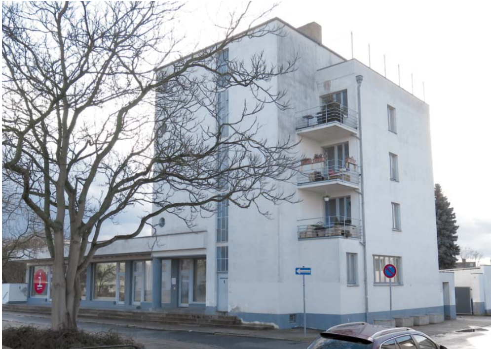
Abbildung 24: Gebäude des Konsumvereins, Dessau-Törten, Ansicht von Nordwest, 2014
