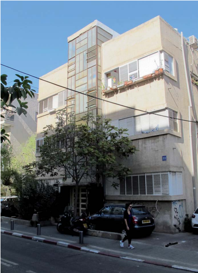
Abbildung 82: aufwendige Stahl-Treppenhausfenster im Schachbrettmuster, Pinsker Street 23, Tel Aviv, 2013
