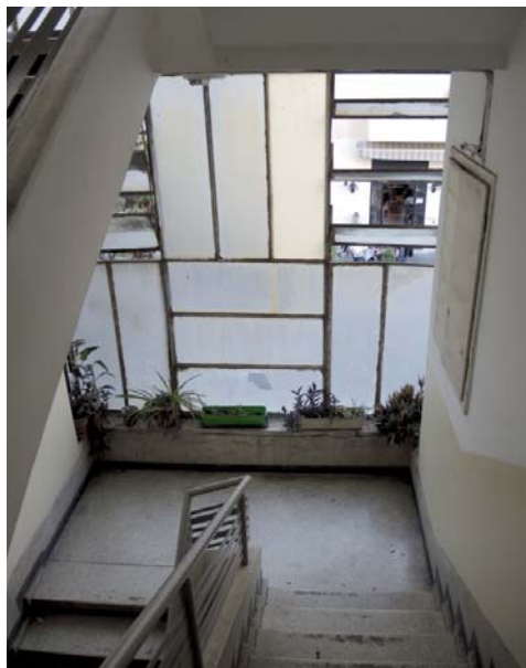
Abbildung 83: Treppenhaus Pinsker Street 23 von innen, Tel Aviv, 2013
