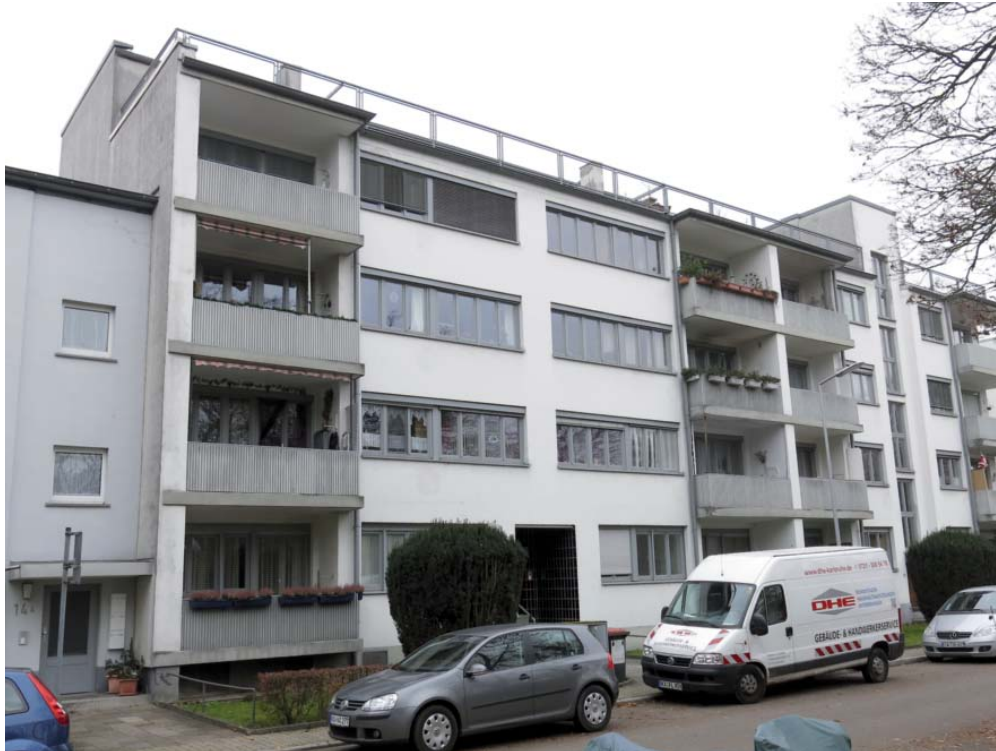
Abbildung 23: Dammerstocksiedlung, Danziger Straße 12–14, Karlsruhe, Ansicht Ost, 2014
