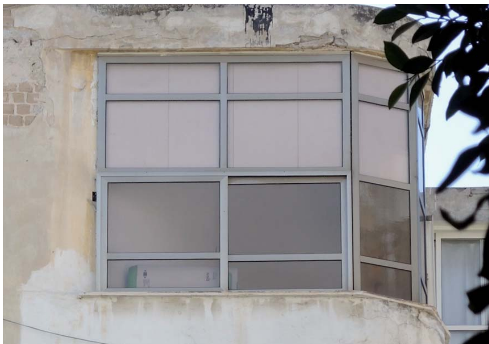
Abbildung 48: nachträglich mit Fensterelementen verschlossener Eckbalkon, Tel Aviv, 2013
