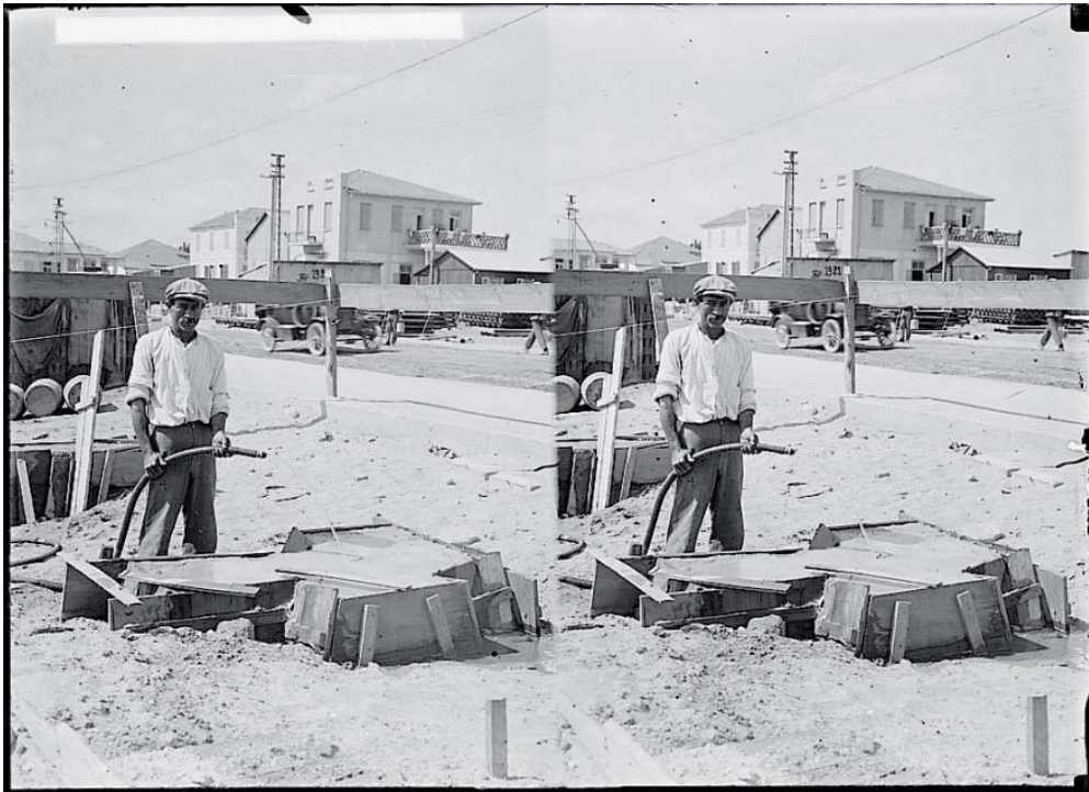
Abbildung 109: Betonierung des Fundaments auf einer Baustelle, Stereofoto, Tel Aviv, um 1930.
