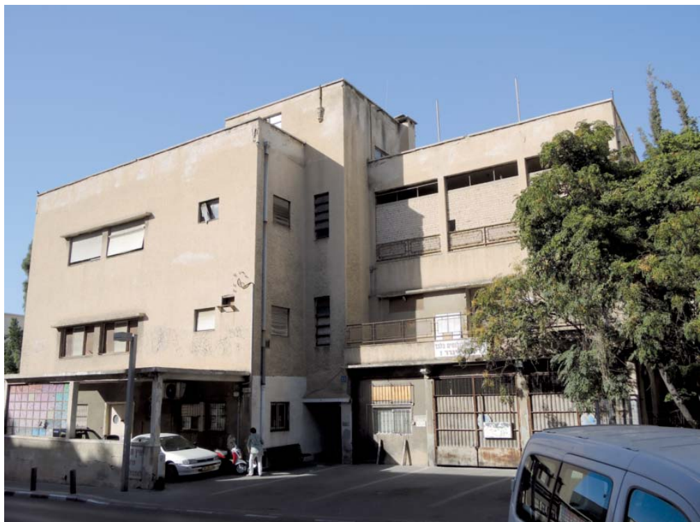
Abbildung 21: Mazeh Street 13, Tel Aviv (Magen David Adom House), Ansicht von Südost, 2013
