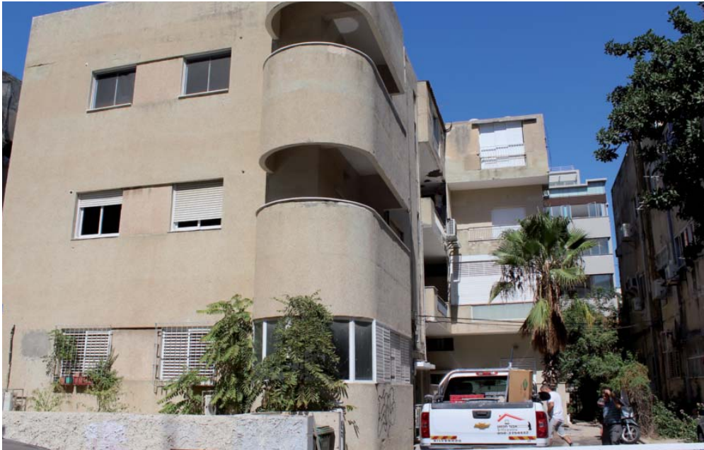
Abbildung 94: Sanierung eines Wohngebäudes im bewohnten Zustand, Rückbau der geschlossenen Balkone Maze Street 31, Tel Aviv, 2013. (Der Eigentümer erwägt den Anbau eines Fahrstuhls.)
