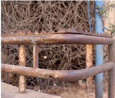
Abbildung 99: Details stählerner Garteneinfassungen, links Vorgarten Idelson Street 14, Tel Aviv, 2013, rechts Vorgarten Nürnberger Str. 3/Danzigerstraße, Karlsruhe-Dammerstock, 2014. An beiden Einfassungen befinden sich gleichartige Zackenreiter auf den oberen Rohren
