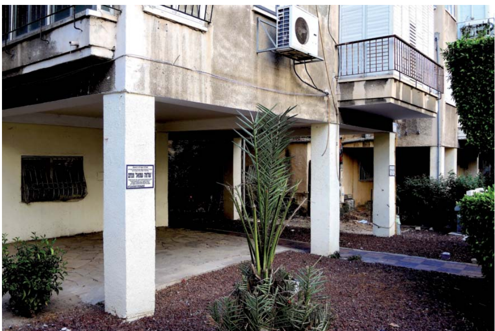
Abbildung 41: Eingangsbereich im Erdgeschoss, zur Straßenseite offen, führt zu optisch breiterer Straße und zur Verschattung des Eingangsbereichs, Tel Aviv, 2013
