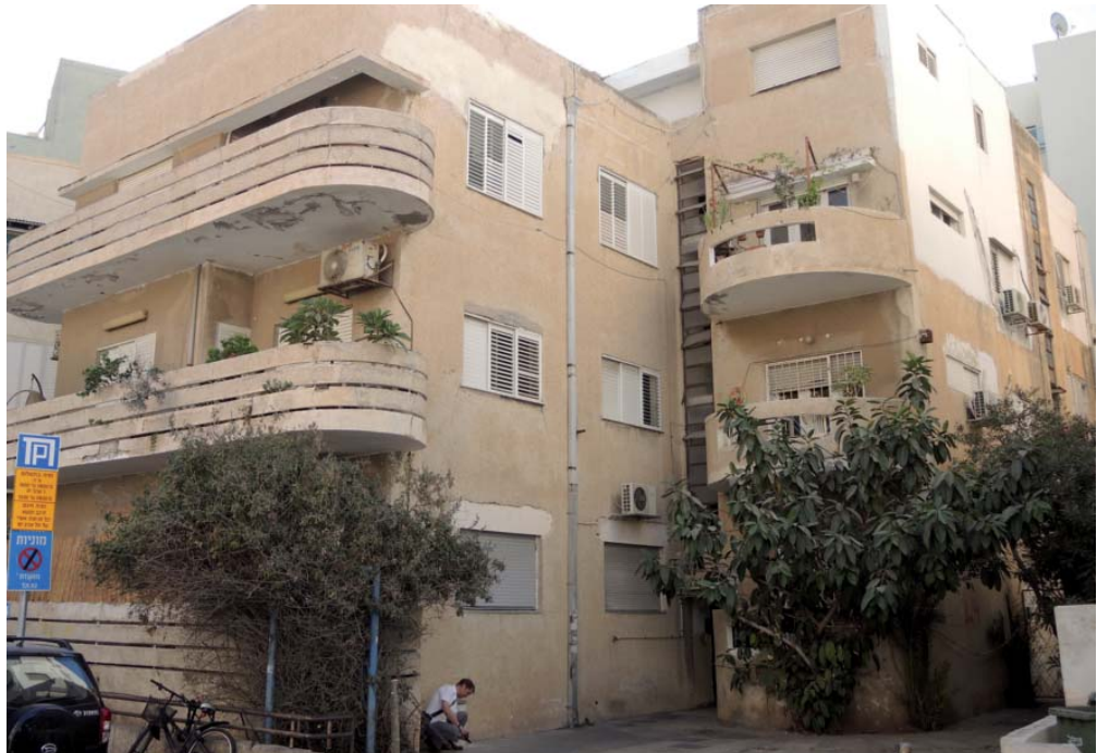
Abbildung 44: Vertikal angeordnete Fenster zur Belüftung des Treppenhauses, Idelson Street 14, Tel Aviv, 2013
