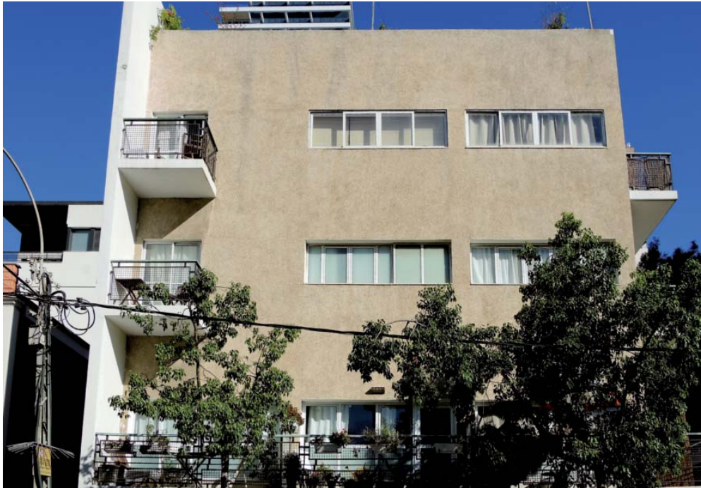
Abbildung 46: Mauersegel (links im Bild) zum Einfangen des Seewinds, Tel Aviv, 2013
