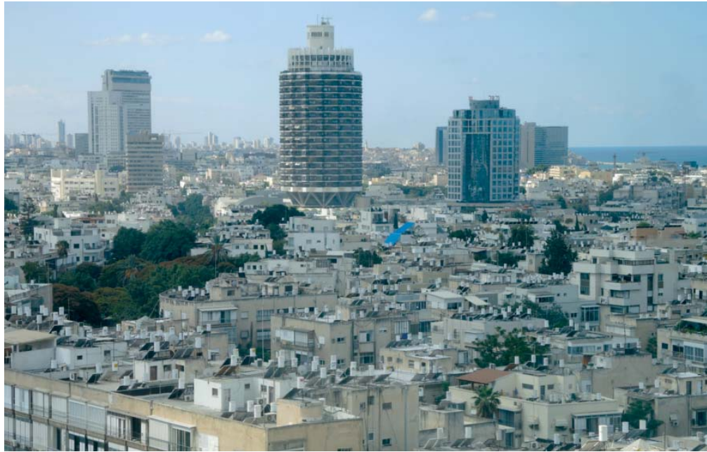
Abbildung 56: Thermosiphonanlagen auf Dächern der Innenstadt Tel Aviv, 2013
