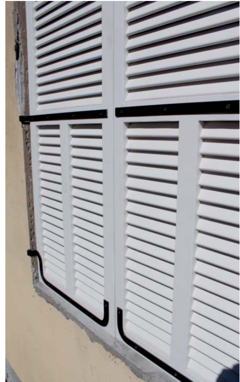
Abbildung 78: ausgetauschte Schlagläden in der Denkmalbaustelle (Baujahr ca. 1920) Derech Jaffa Street 13, Tel Aviv, 2013
