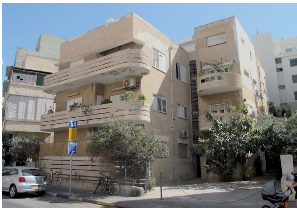
Abbildung 19: Haus Proschneider in der Idelson Street 14, Tel Aviv, Ansicht von Nordwest, 2013
