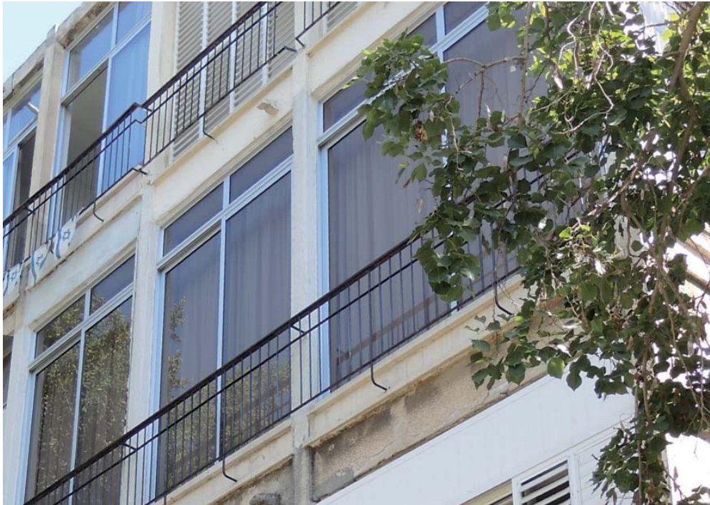
Abbildung 49: verglaste Balkone mit innen liegendem Sonnenschutz, Tel Aviv, 2013
