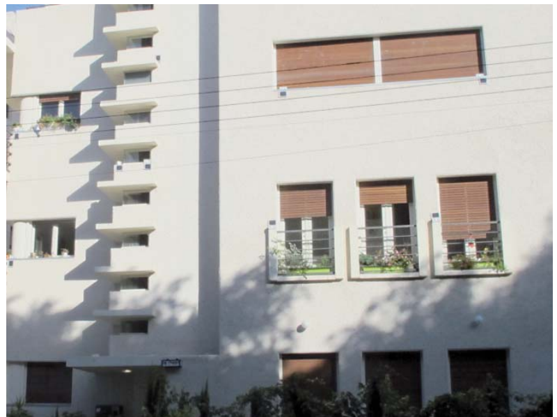
Abbildung 43: Außen liegende Verschattung mit horizontalen Betonvorsprüngen (links) und Rollläden (rechts), Tel Aviv, 2013
