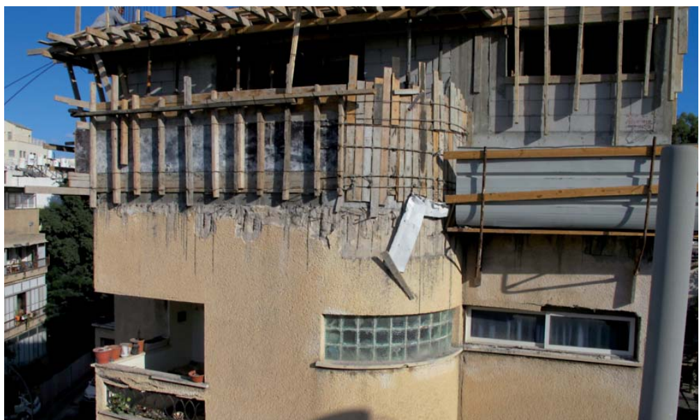
Abbildung 9: Baustelle einer aktuellen Aufstockung auf einem Wohngebäude in der Aharonovitch Street, Tel Aviv, 2013
