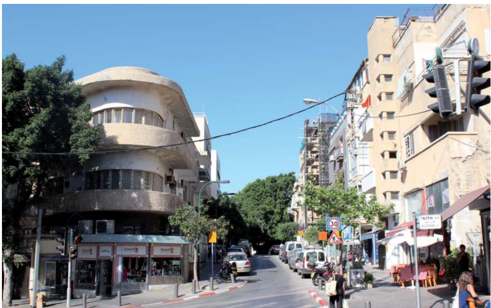
Abbildung 66: Wohnbebauung Allenby Street/Ecke Moshe Hess Street, Tel Aviv, 2013
