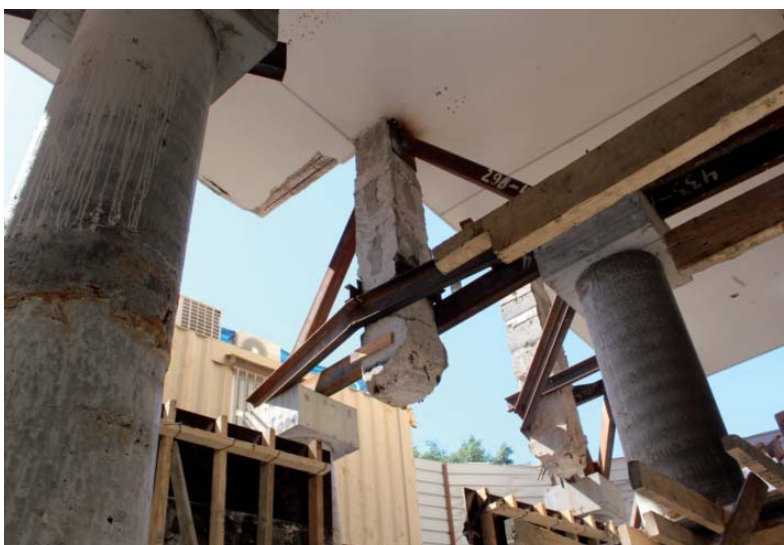
Abbildung 97: abgefangene Pilotis 82 zwischen neuen Säulen (Untersicht aus dem neuen Tiefgeschoss), Sderot Hen Street 38, Tel Aviv, 2013
