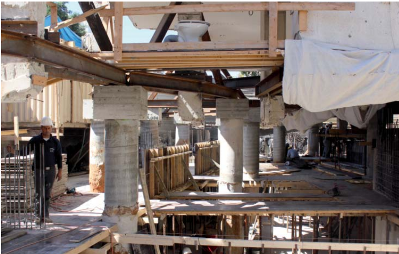
Abbildung 96: Großbaustelle Sderot Hen Street 38, Tel Aviv, 2013
