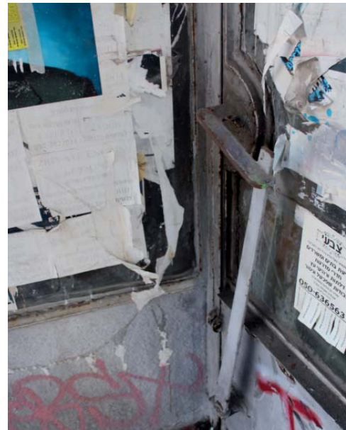
Abbildung 84: vollständig erhaltene Stahlrahmen-Glastür (Ladeneingang), Allenby Street 52, Tel Aviv, 2013
