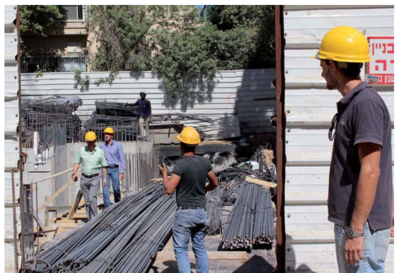
Abbildung 95: Vorbildliche Baustellenführung durch Generalunternehmer. Gleichzeitig hoher Substanzverlust am Gebäude und an den Außenanlagen aufgrund der weitreichenden Maßnahme (Sderot Hen Street 38, Tel Aviv, 2013)
