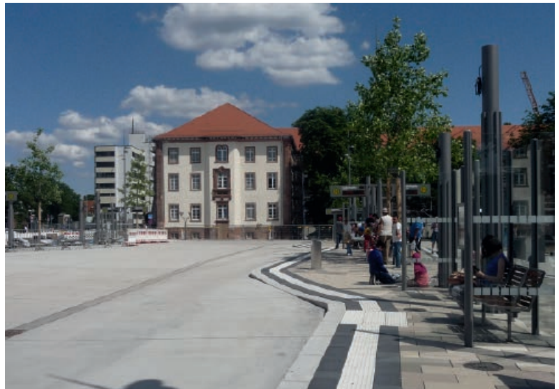
Leitsysteme für Sehbehinderte werden zumeist bei Umbaumaßnahmen realisiert. Hier der neue ZOB am Freiheitsplatz in Hanau.
