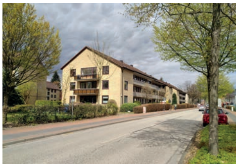
Die Bestandsgebäude an der Rudolf-Breitscheid-Straße
