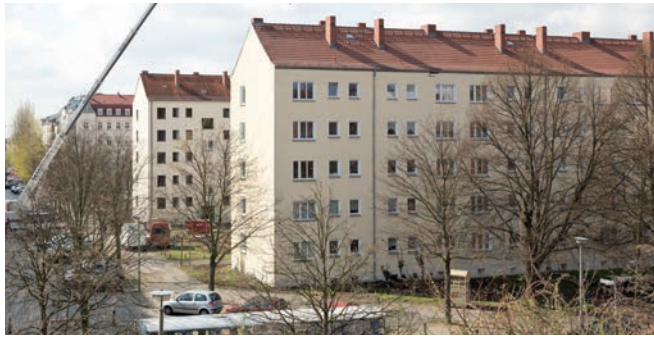
Bestandsgebäude vor der Nachverdichtung
