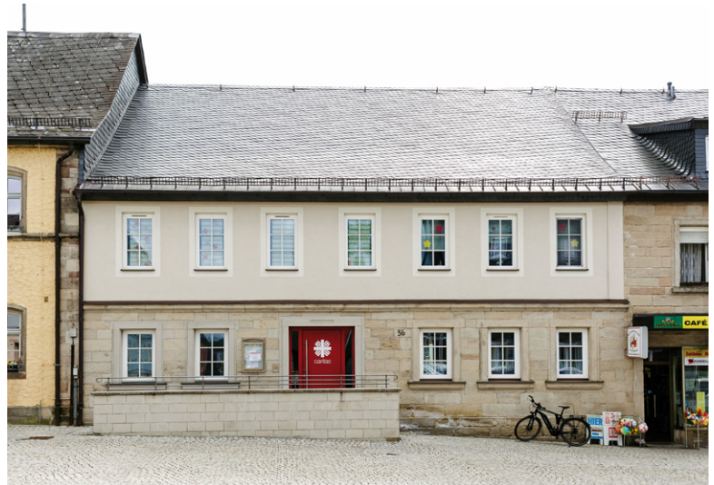
ARGE Rennsteig: Sanierte Fassade des Altbaus am Marktplatz von Teuschnitz
