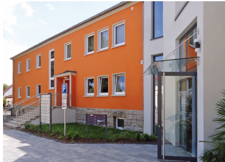
Geisa: Außenansicht des Ärztehauses nach der Sanierung
