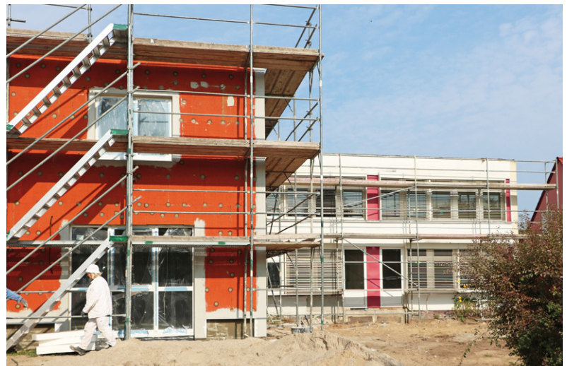
Mittelbereich Seelow: Energieeffiziente Sanierung und Erweiterung einer Kita in der Gemeinde Neuhardenberg
