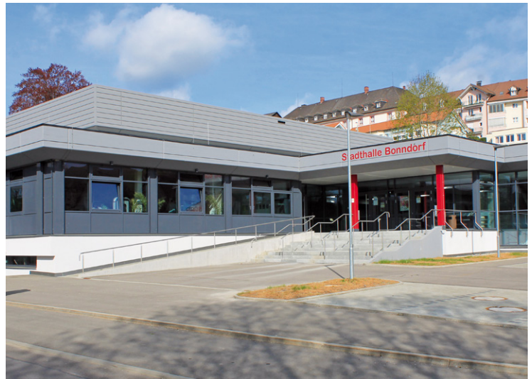
Bonndorf: Sanierte Stadthalle
