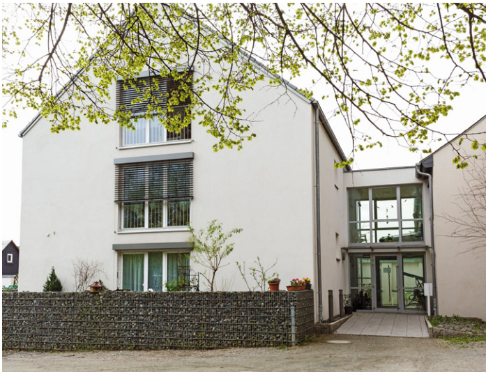
ARGE Rennsteig: Erweiterungsbau des Wohnprojekts in Teuschnitz
