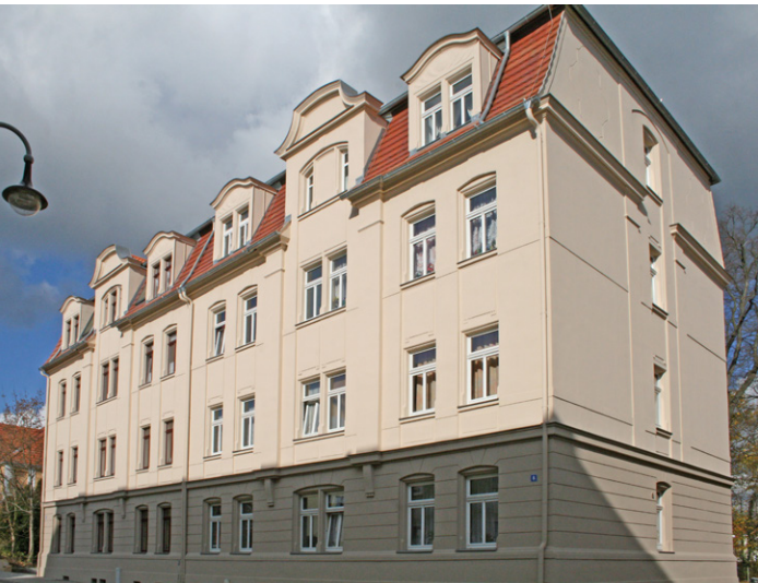
Niesky: Saniertes Wohnhaus
