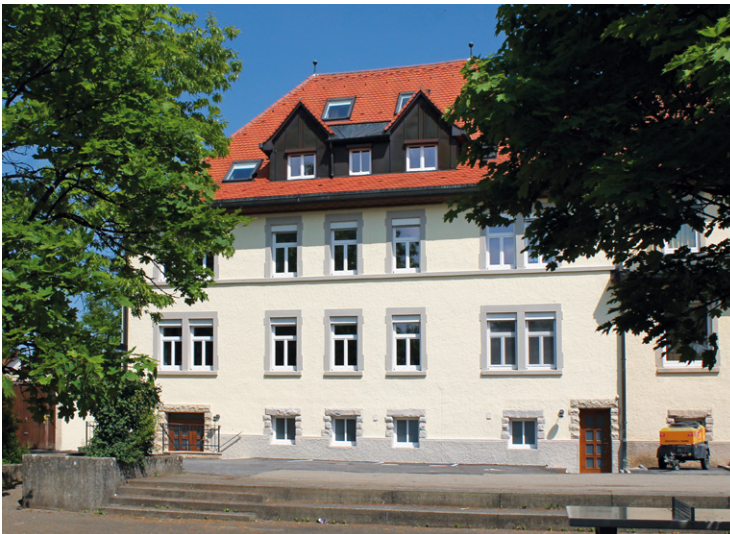
Hülben: Bürgerhaus im ehemaligen Schulhaus nach der Sanierung
