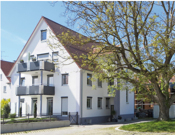
AG Bachtal: Landwirtschaftliche Hofstelle nach dem Umbau
