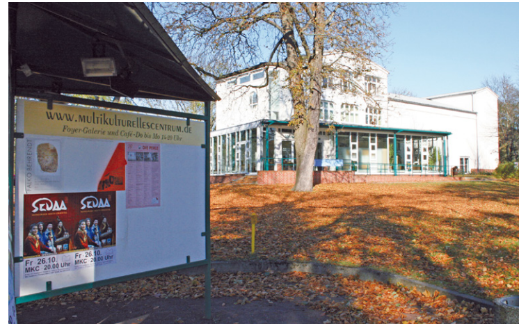
Mittelbereich Templin: Multikulturelles Zentrum
