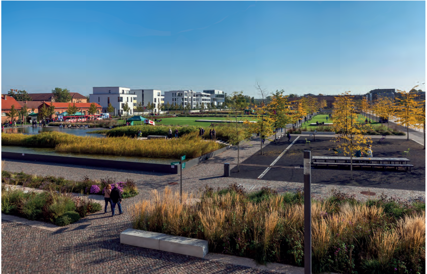
Die ersten realisierten Neubauten (Musterhäuser) und Bestandssanierungen am Rande der Landesgartenschau, Landschaftsarchitektur: A24 Landschaft, Foto: Hanns Joosten
