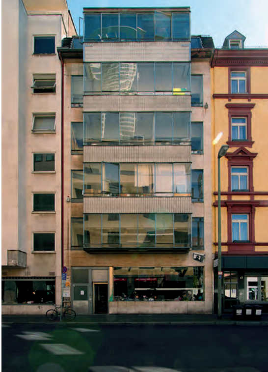
Das Gebäude in der Niddastrasse 59 vor der Sanierung, Foto: Ulrich Becker
