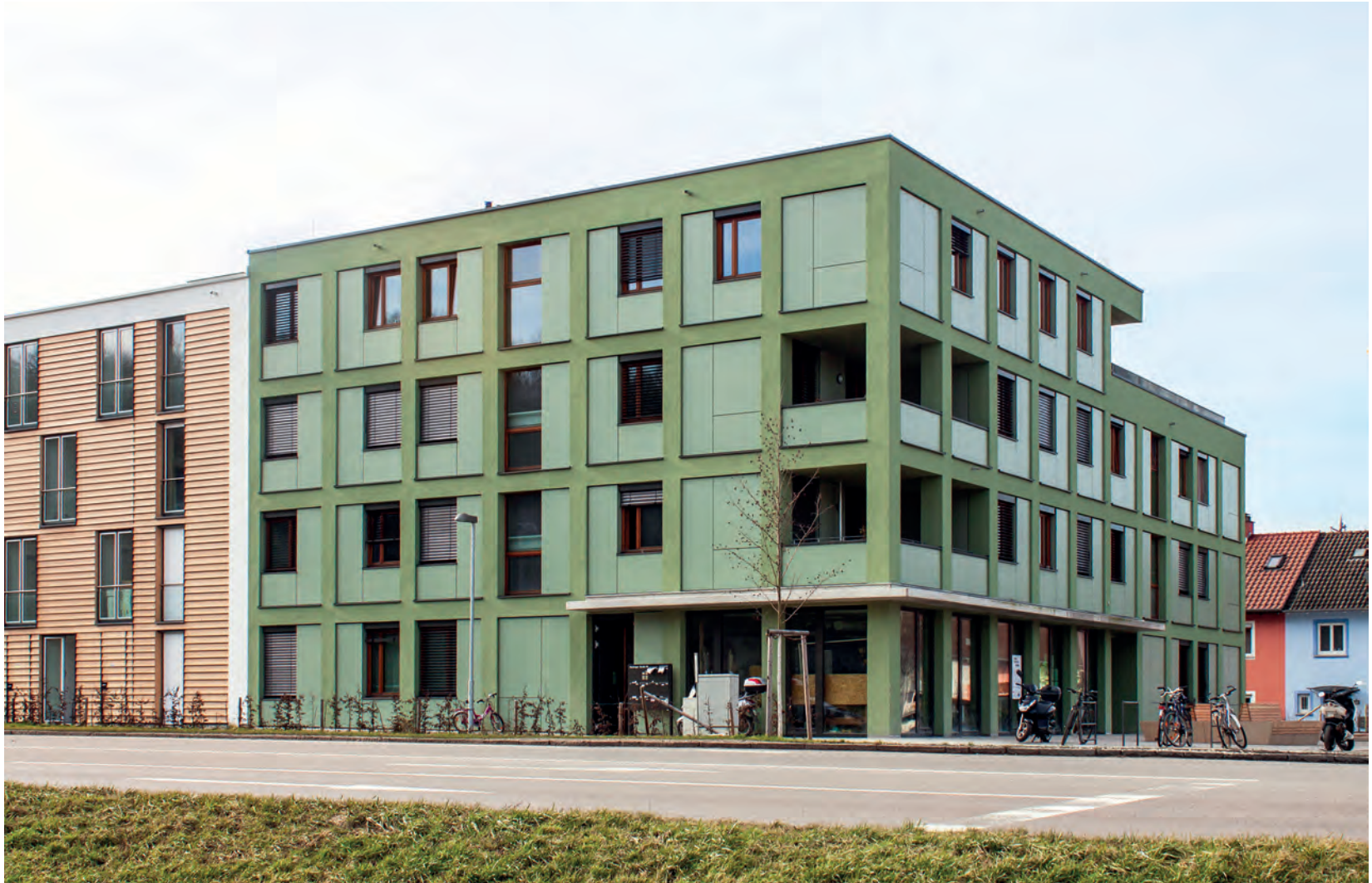
Das Baugemeinschaftsprojekt Passerelle am Standort Hechinger Eck Süd, Architektur: ackermann + raff Architekten, Projektentwicklung und -steuerung: jungarchitektur, Foto: Claudia Jung
