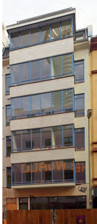
Das Bestandsgebäude von Niddastern im Bau, die neuen Stahlrahmenfenster sind bereits eingebaut, Foto: RT
