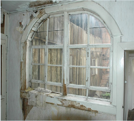
Detail vor der Sanierung
