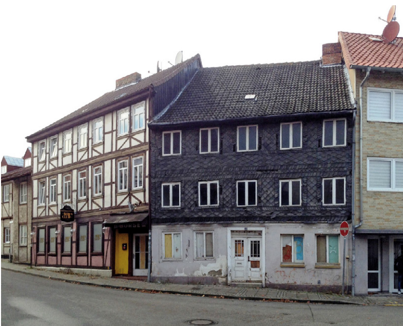
Bei erkennbaren städtebaulichen Missständen greifen die städtebaulichen Gebote des BauGB.
