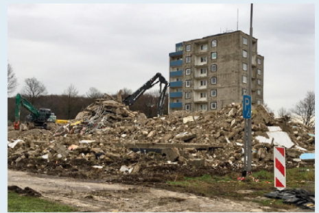
Die Wohngebäude während des Abbruchs
