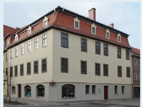
Städtebaulich bedeutsames Eckgebäude vor und nach der Sanierung
