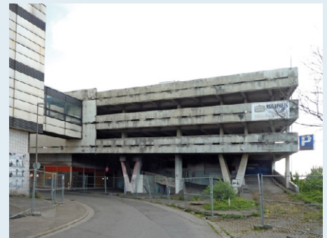
Parkhaus vor dem Abbruch
