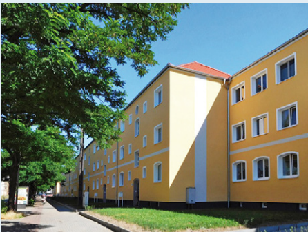
Wohngebäude in Alt-Salbke vor und nach der Sanierung
