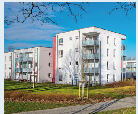
Wohnhochhaus vor Abriss und neu errichtete Gebäude
