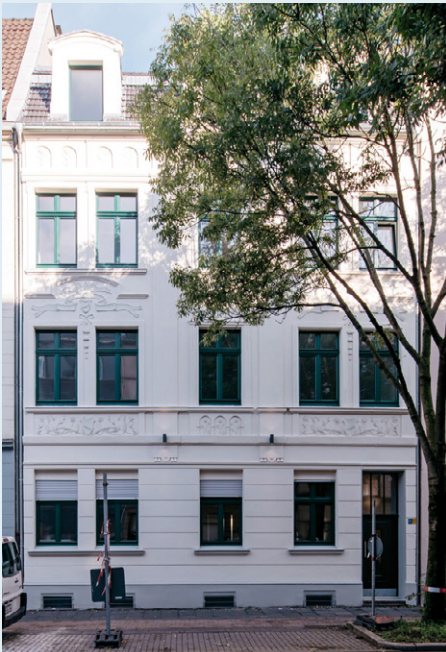
Gebäude in der Dortmunder Nordstadt vor und nach Sanierungsmaßnahmen
