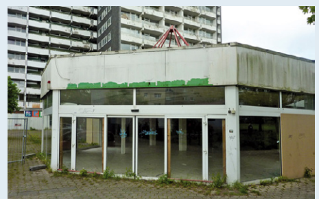
Gebäudekomplex vor dem Rückbau
