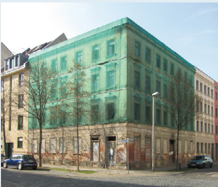
Denkmalgeschütztes Eckgebäude vor der Sanierung
