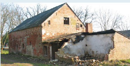
Die ehemalige Dornbuschmühle Vervais
