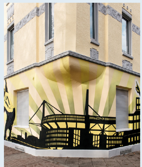
Eckgebäude in der Dortmunder Nordstadt vor und nach Sanierungsmaßnahmen
