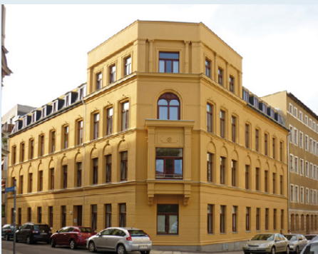
Stadtbildprägendes Eckgebäude vor und nach der Sanierung
