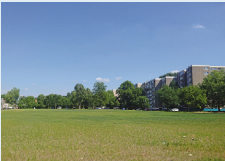
Wohngebäude im Quartier Wollepark vor, während und nach dem Abriss
