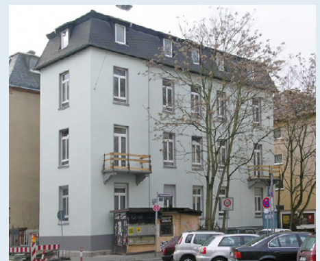
Instandhaltungs- und Sanierungsrückstau und Gebäude nach der Sanierung
