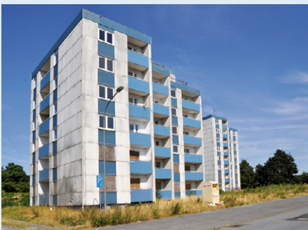
Die Wohngebäude vor dem Abbruch
