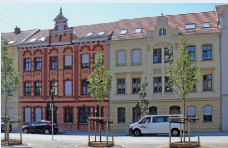
Gebäude im Jahnshulviertel vor und nach der Sanierung
