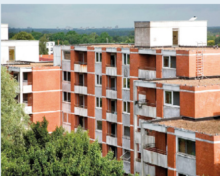
Das Objekt in der Magdeburger Straße vor dem Rückbau
