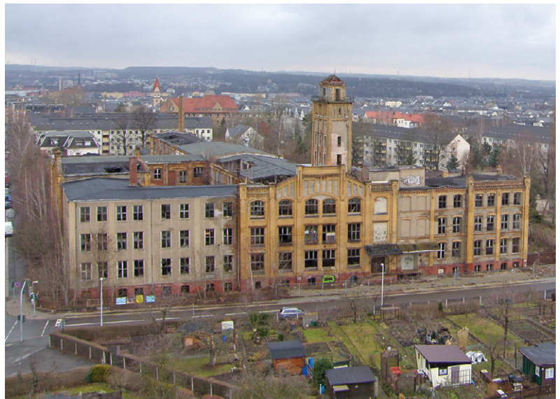
Die Revitalisierung solcher Industrie- und Gewerbebrachen kann eine Initialzündung für die Quartiersentwicklung sein.
