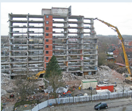
Glaspalast vor und während des Abbruchs
