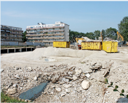
Albrecht-Dürer-Allee während der Rückbaumaßnahmen (oben), Berliner Ring vor und nach dem Abbruch (Mitte und unten)
