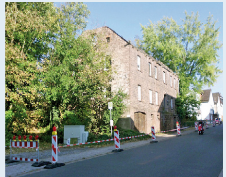
Zum Abbruch vorgesehene Objekt in Fürstenberg
