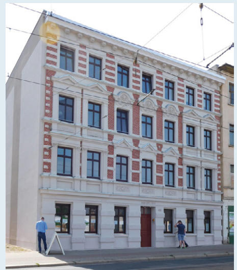
Gründerzeitgebäude in Alt-Fermersleben vor und nach der Sanierung
