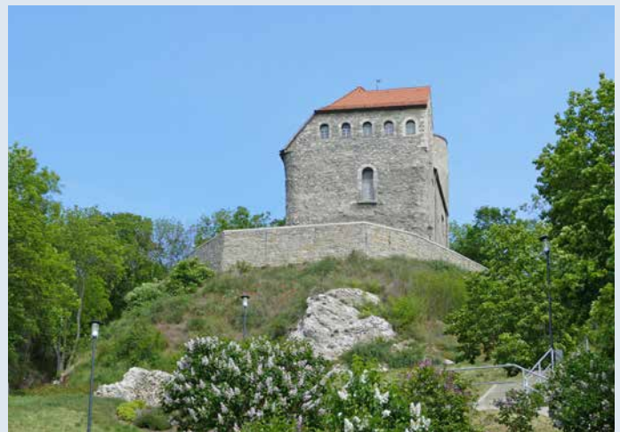
Hausmannsturm nach der Sanierung
