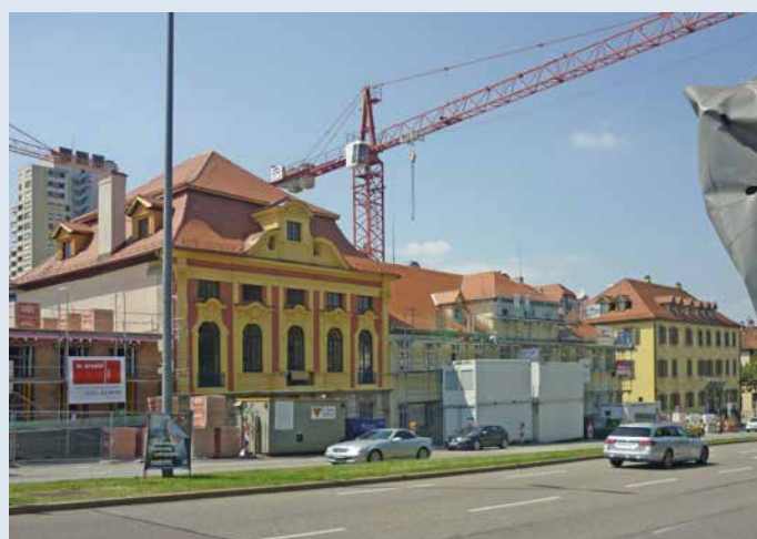
Sanierung stadtbildprägender Gebäude
