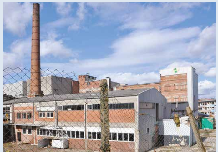
Höll-Areal vor der Umstrukturierung
