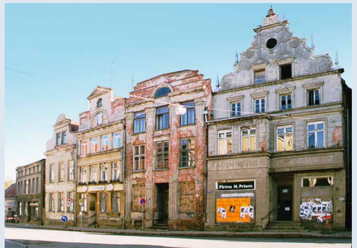
Gebäudezug vor der denkmalgerechten Sanierung
