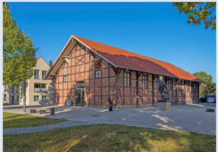
Bürgermuseum in umgebauter und sanierter historischer Turnhalle
