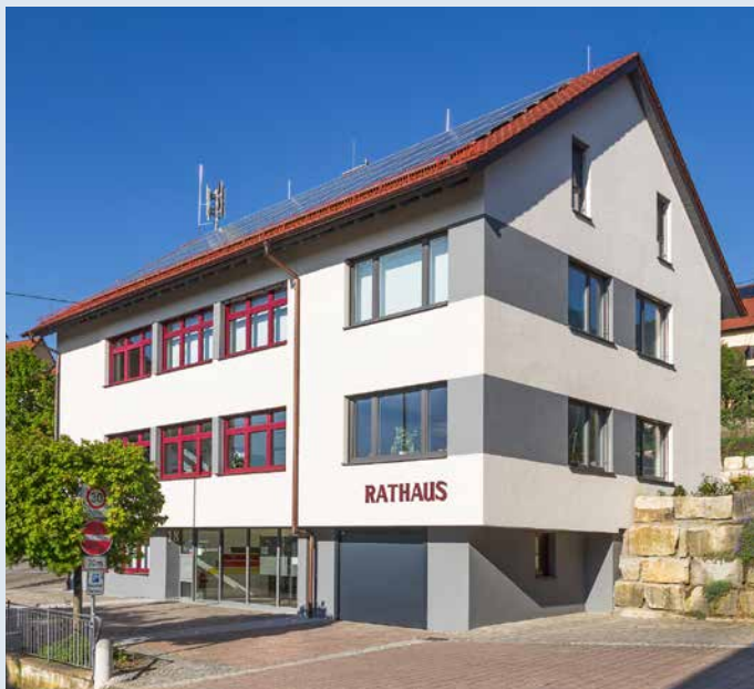
Rathaus nach Umbau und Sanierung mit barrierefreiem Zugang
