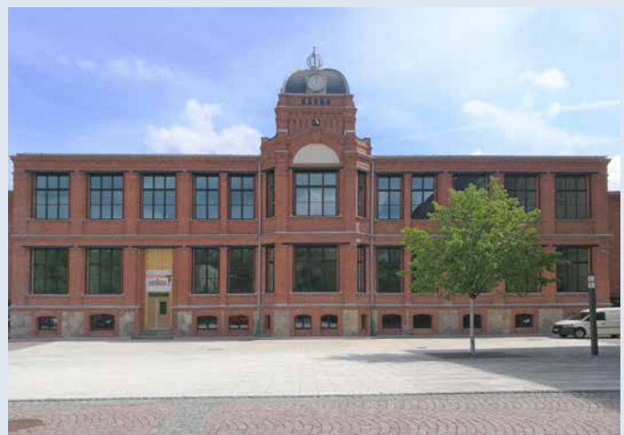
Im Umbau befindliches Verwaltungsgebäude zum neuen Rathaus
