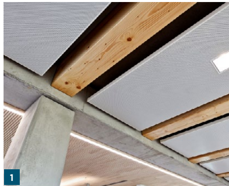
1 Holz-Beton-Verbund-Decke mit zwischen den Rippen angeordneten TGA-Registern 2 Mit Epoxidharzmörtel geklebter Scherversuchskörper nach Scherversagen des Holzes 3 Zwischen den Balken angeordnetes TGA-Register 4 Der untersuchte Polyurethan-Klebstoff
