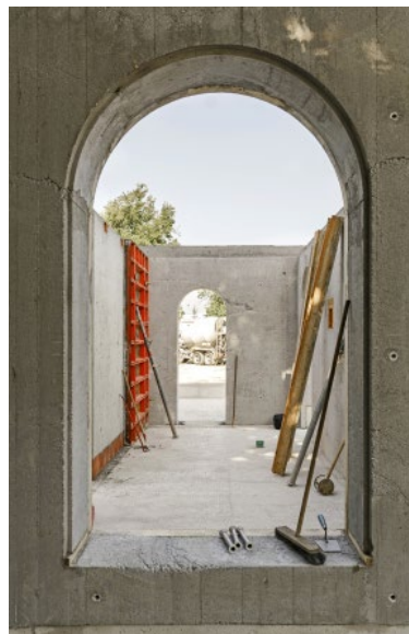
Gebäude Leichtbeton: Rohbauarbeiten im Erdgeschoss
