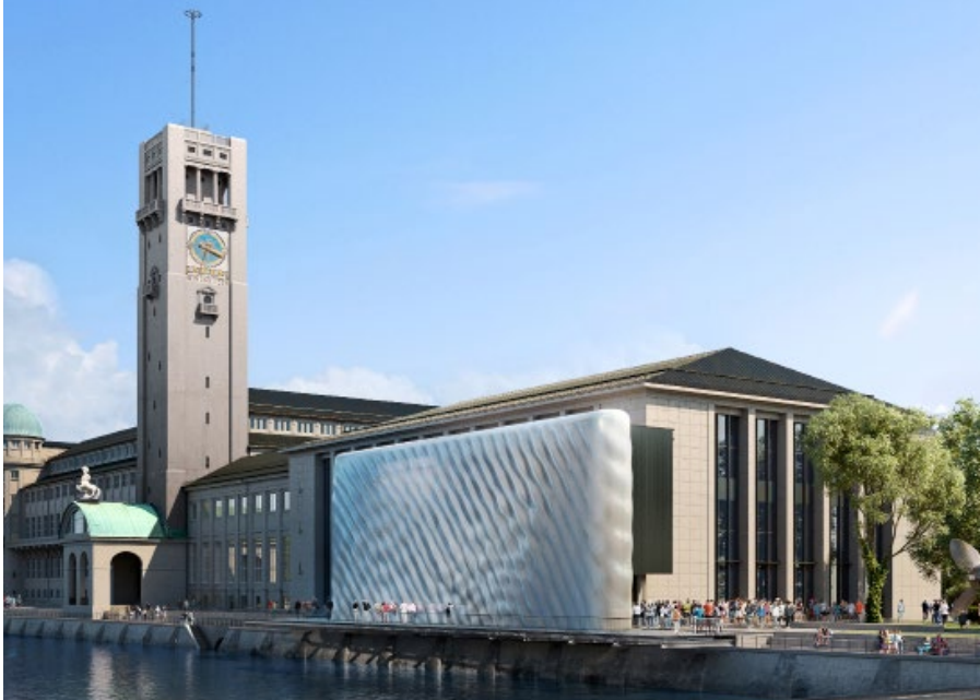
Fassade der Zukunft: 3D-gedruckte und recycelbare Fassade am Interimseingang Deutsches Museum München (r.). Ursprüngliche Variante mit 750 m 2 Fassadenfläche (l.)
