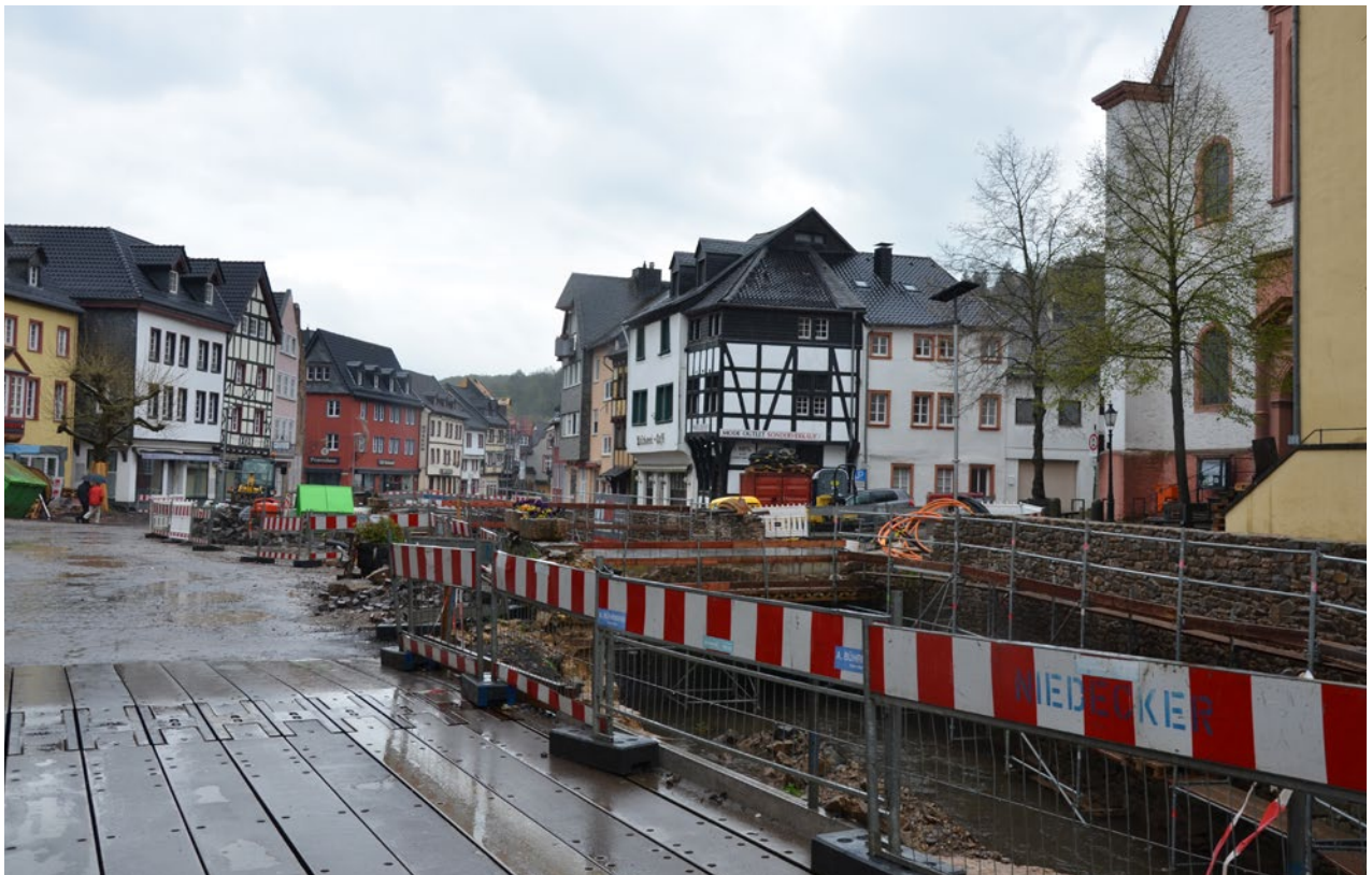
Wiederaufbaumaßnahmen entlang der Erft im historischen Stadtkern von Bad Münstereifel (Foto: RHA)
