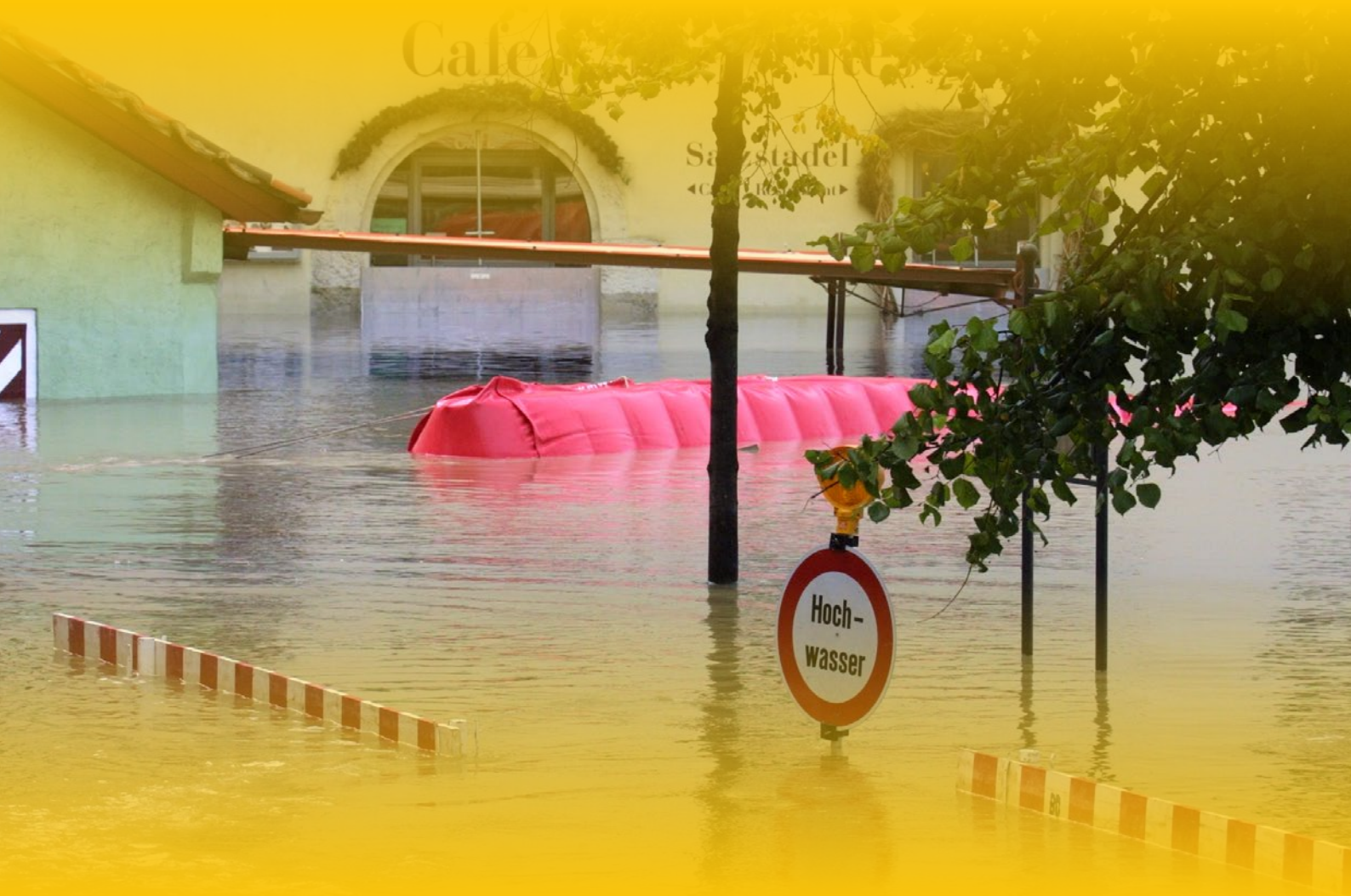
Das Schild zur Hochwasserwarnung versinkt im Wasser vor dem Besucherzentrum Welterbe Regensburg im Salzstadel (Foto: Stadt Regensburg)
