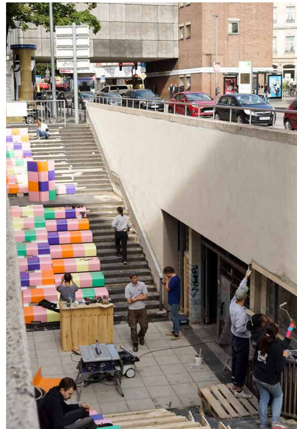
Die Studierenden montieren die farbigen Sitzstufen auf die ehemalige Treppenanlage. © Ivo Mayr
