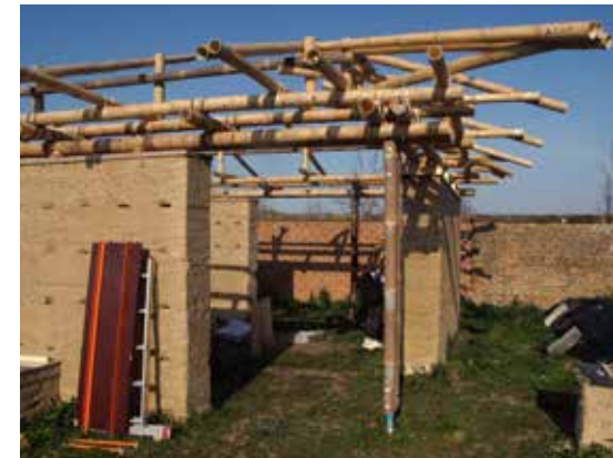
Oben: Dachkonstruktion aus Bambus auf frei stehenden Stampflehmwänden. © Nicola Paternuosto
