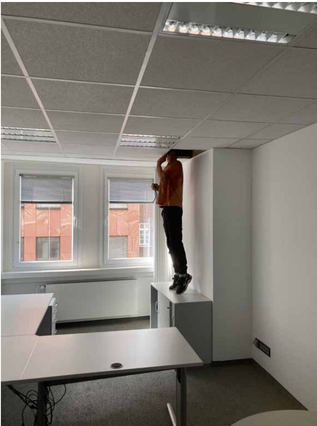
Untersuchungen der Rohbaustruktur im Bestandsgebäude. © Christoph Henschel
