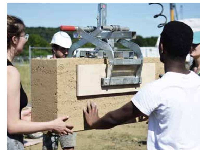
Unten: Versatz der Blöcke mittels Minikran und Greifzange. © Philipp Hoppe
