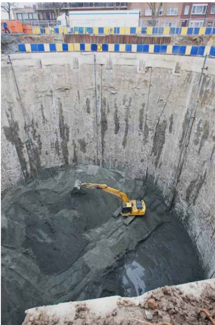
Oben: Baustelle von BC architects, Wiederverwendung von Erdaushüben. © DeMeuter
