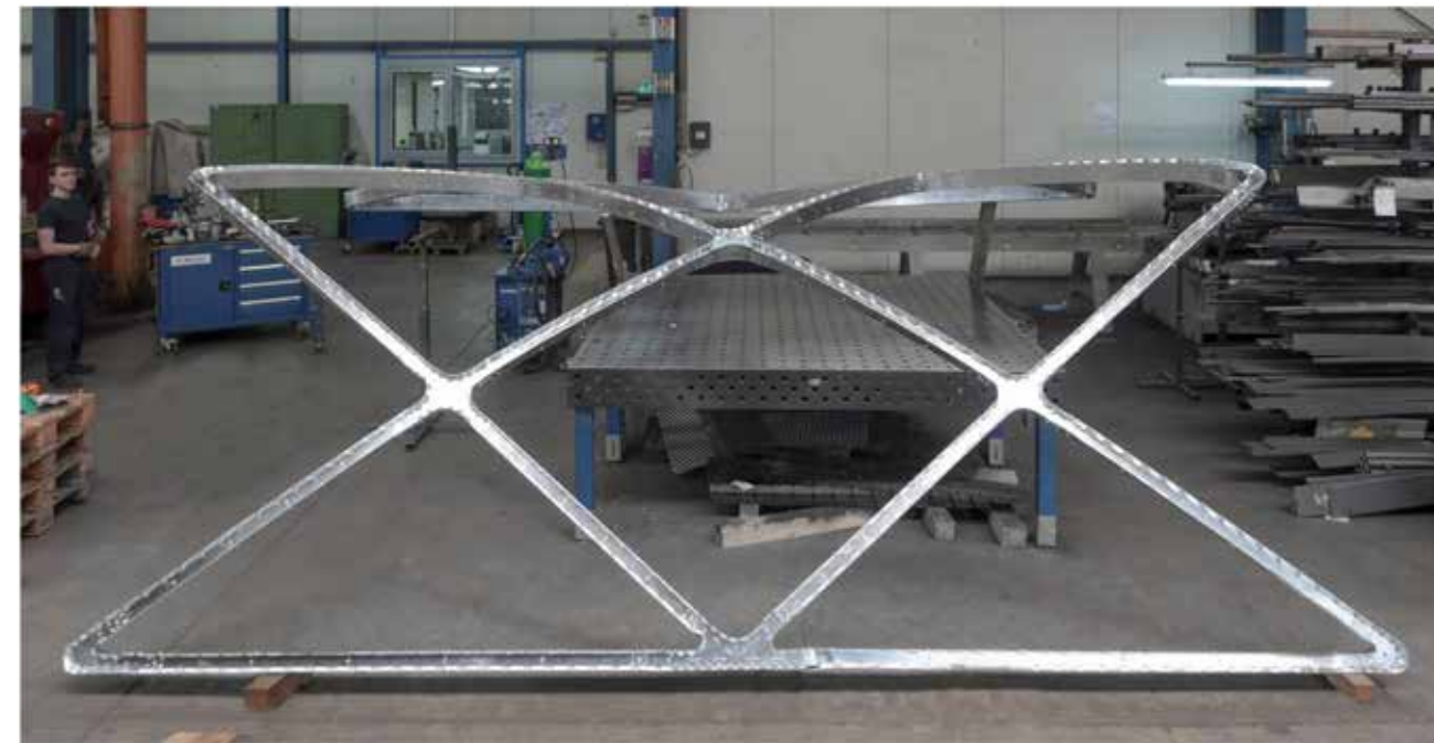
Oben: Vormontage der Träger mittels Knotenelementen. © Mona Schmidt
