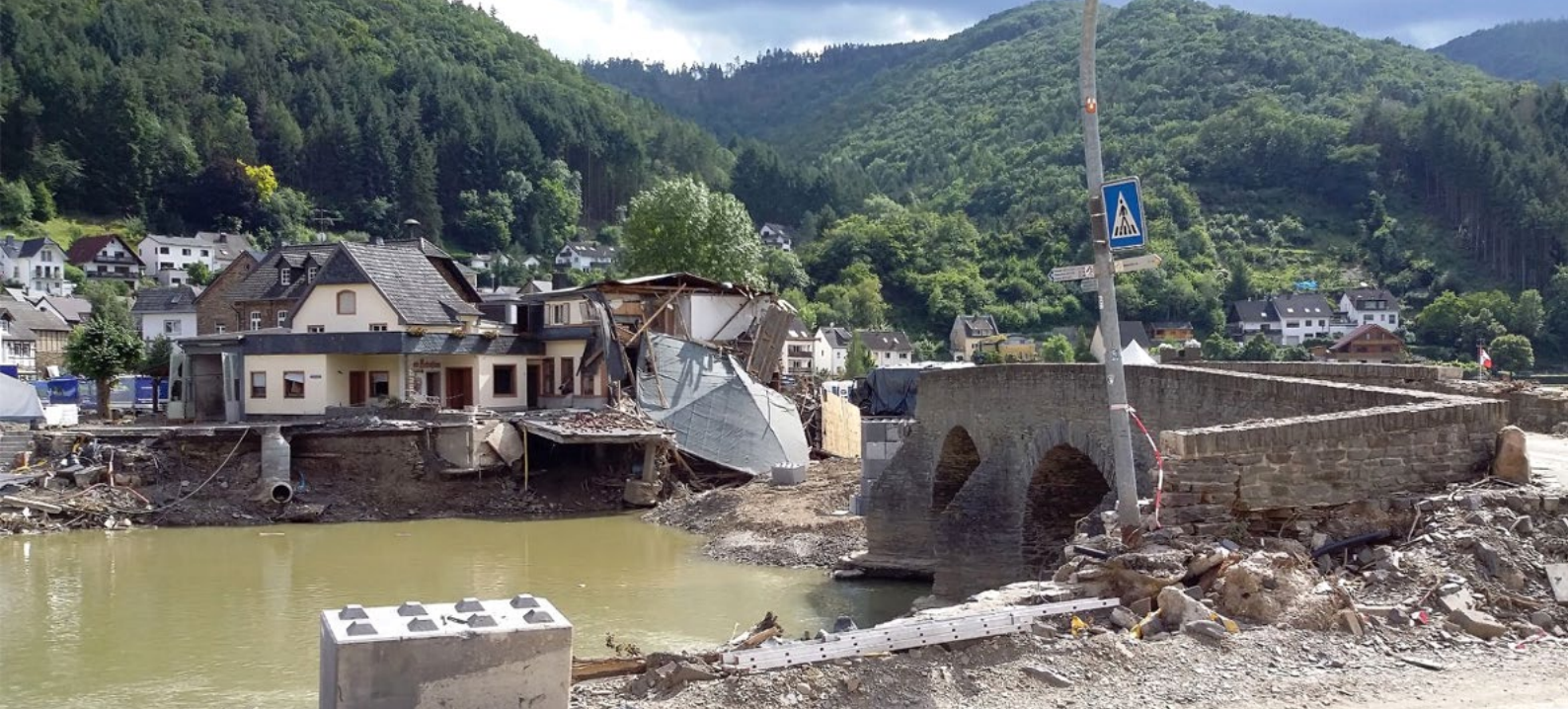
In der Nacht zum 15. Juli 2021 trat die Ahr meterhoch über die Ufer und zerstörte die Nepomukbrücke bei Rech, wie hier im Bild zu sehen | Quelle: Fraunhofer FKIE/Ralf-Michael Vette
