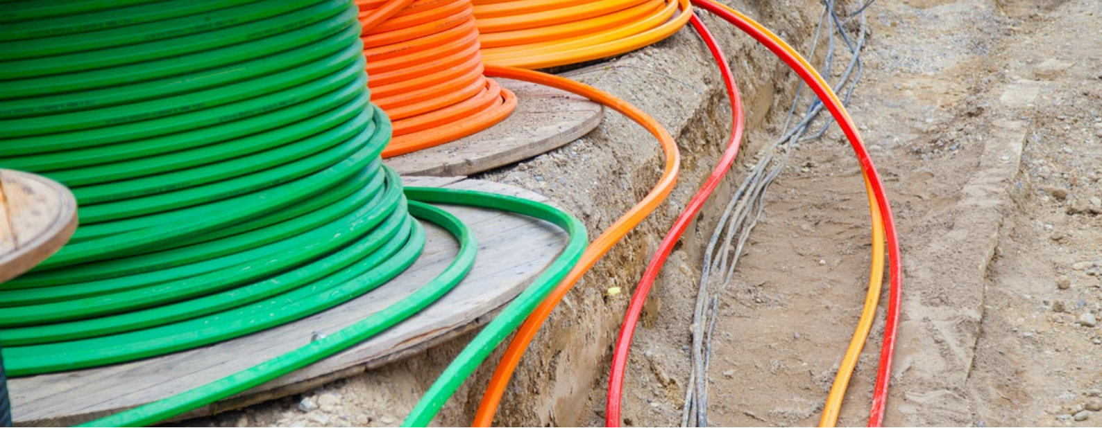
Verlegung von Glasfaserkabeln | Quelle: Jan Schuler – stock.adobe.com
