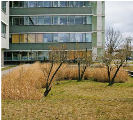
In der Schwammstadt werden Versickerungsflächen angelegt. Diese halten das Wasser und verringern den Oberflächenwasserabfluss, erhöhen die Grundwasserzufuhr und die Verdunstung. Foto: Reinaldo Coddou H.
