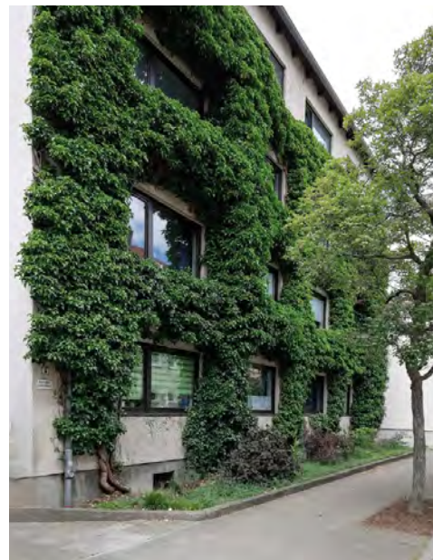
Bodengebundene Begrünung kühlt das Gebäude und hat einen geringeren Pflegeaufwand als wandgebundene Begrünung. Foto: Falko Feldmann
