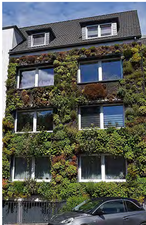
Wandgebundenes Grün ermöglicht einen hohen Gestaltungsspielraum und ersetzt Glas, Metalle oder andere Fassadenelemente. Foto: Bundesverband GebäudeGrün
