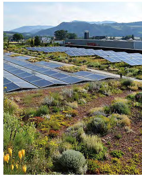
Trockenresistente Begrünung für das Dach erhöht die Biodiversität, die Effizienz von Solaranlagen und isoliert das Gebäude. Foto: Bundesverband GebäudeGrün
