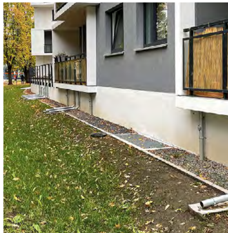
Die Wasserzufuhr von der versiegelten Dachfläche ermöglicht eine Zwischenspeicherung im Boden der begrünten Fläche und erhöht damit das Verdunstungspotenzial. Foto: Gregor Langenbrinck
