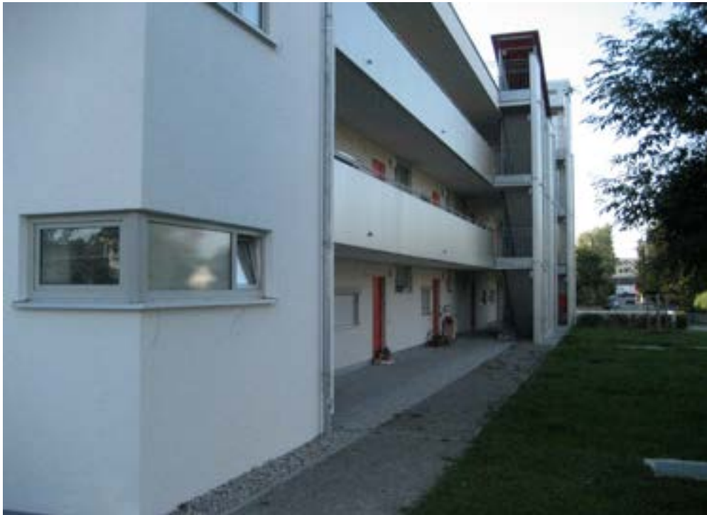
Foto: EM Blick auf die Laubengängerschließung des Wohnexperiments Bobingen
