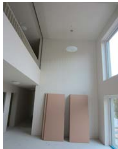
Halle in der Bauphase während Ausbaurbeiten Foto: EM
