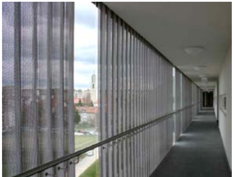
Erschließungsgang (Laubengang) Seniorenwohnungen Foto: Paul Ott
