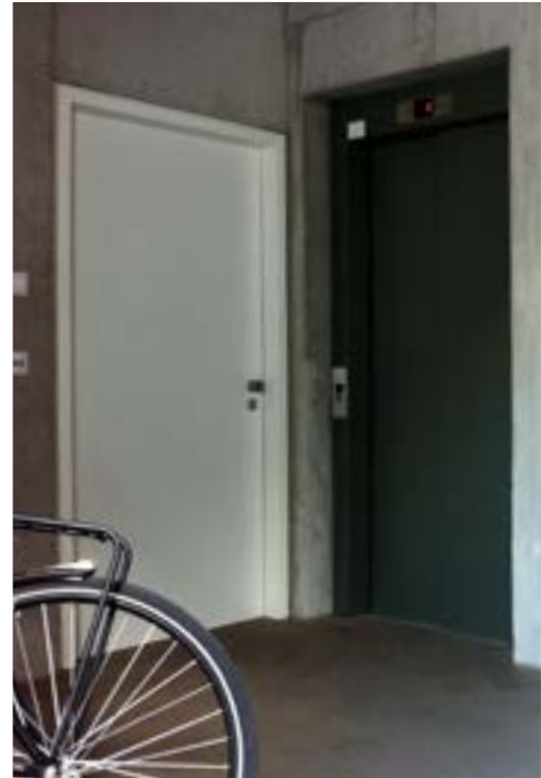
Zugang Wohnung und/oder Aufzug Foto: EM
