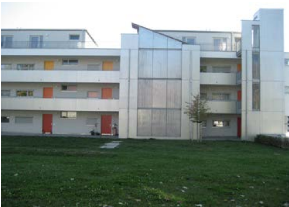
Nord-Ost-Fassade mit Aufzugsturm und eingehauster Treppe an den Außengängen
