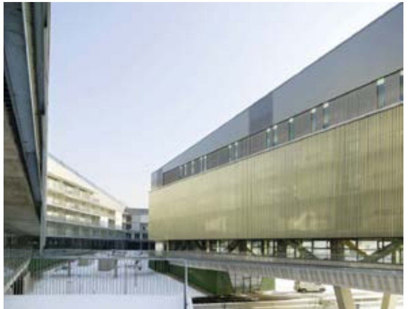
Blick in den Außenraum auf die Balkone der Seniorenwohnungen Foto: Paul Ott
