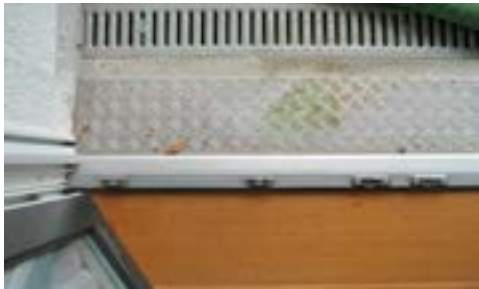
Zugang Loggia (Aufsicht)
