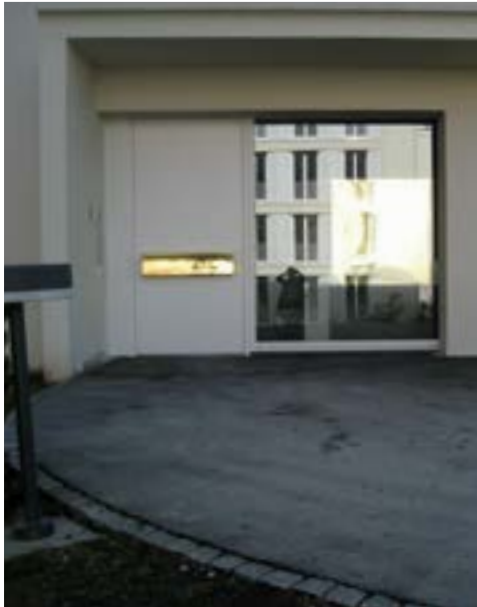
Hauseingang mit geneigter Zuwegung Foto: EM
