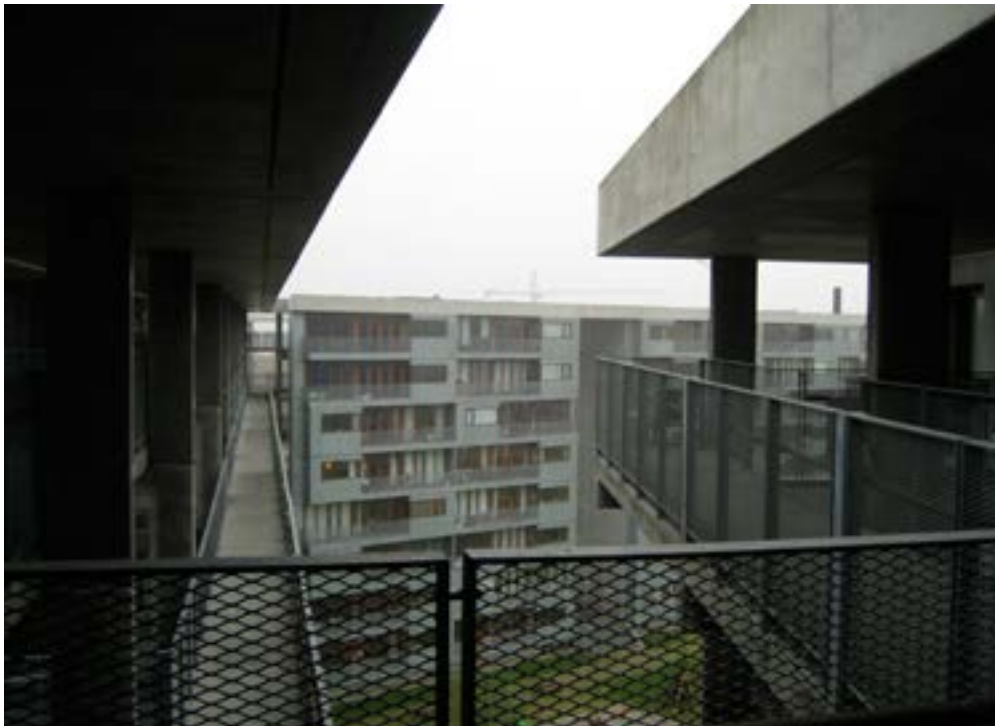
Foto: EM Blick vom obersten Laubengang des Faelledhaven Gebäudes auf die gegenüberliegende Fassade
