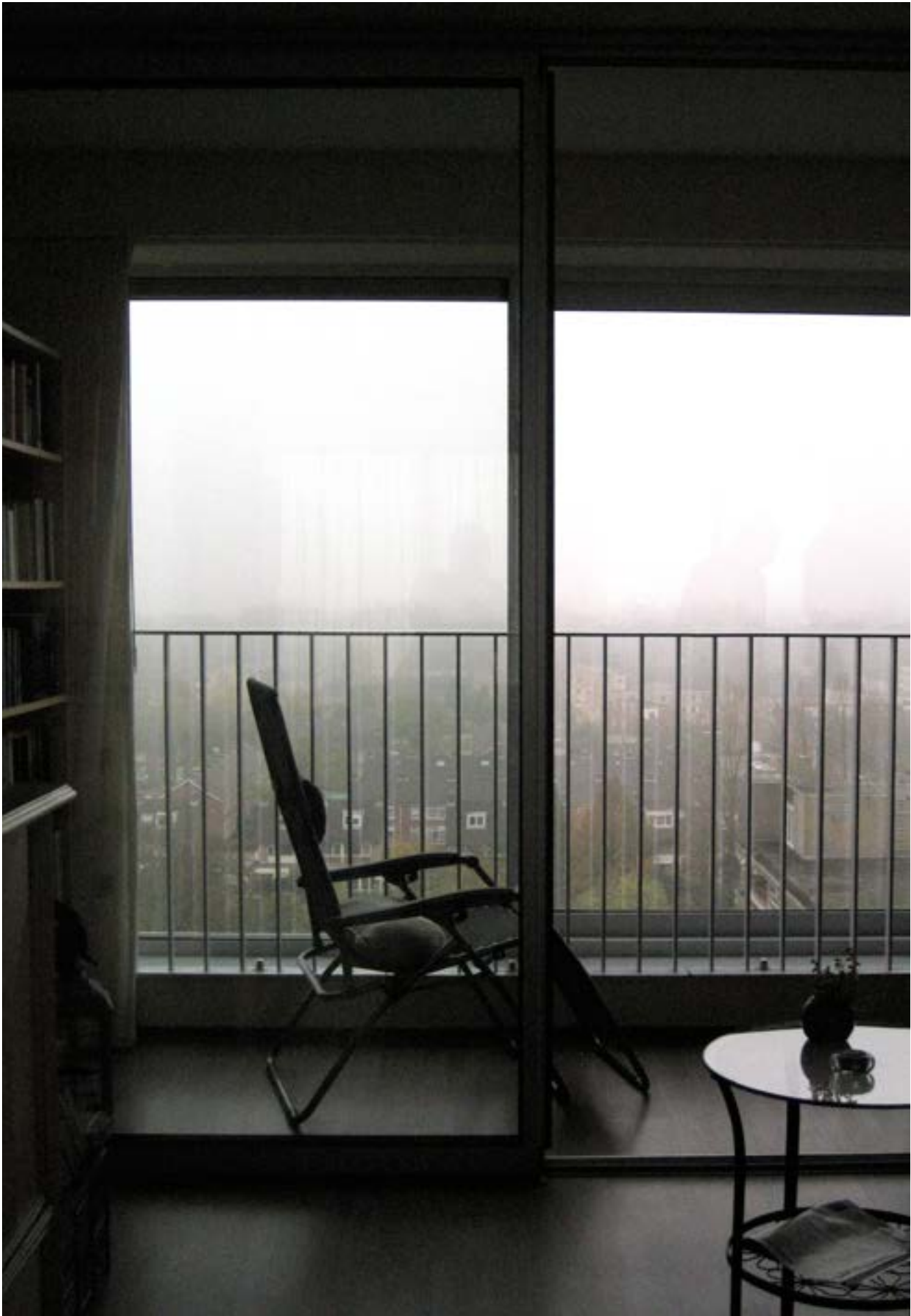
Loggia als Wohnraumerweiterung mit beidseitiger Isolierverglasung
