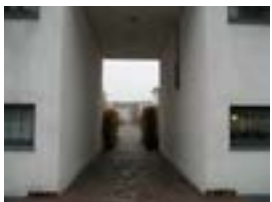
2-geschossiger Durchgang Foto: EM
