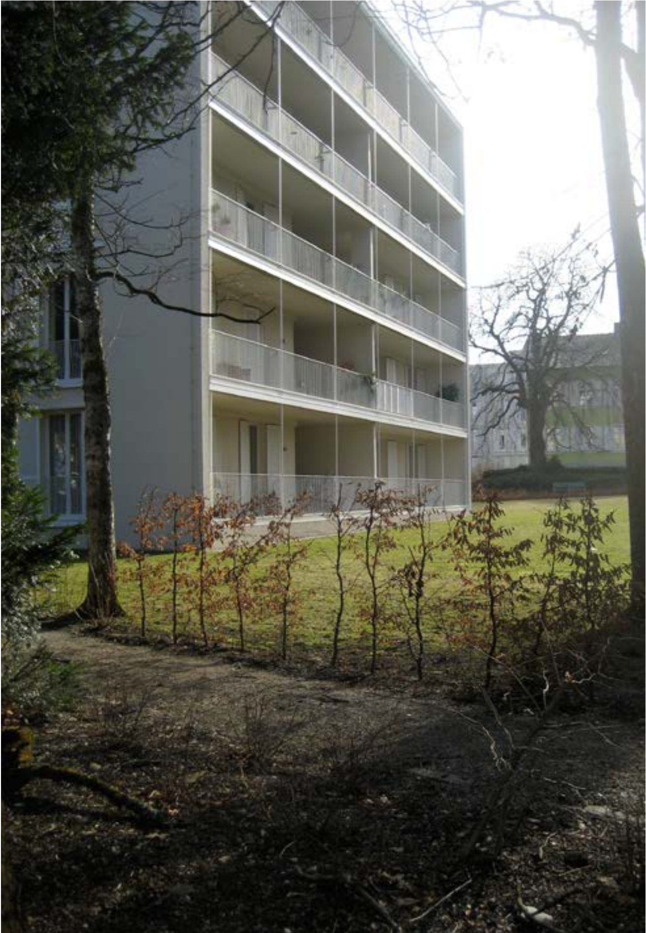
Blick von Norden in den Kurpark auf die filigrane Fassade einer Parkvilla mit nach Westen ins Grün orientierten geräumigen Loggien
