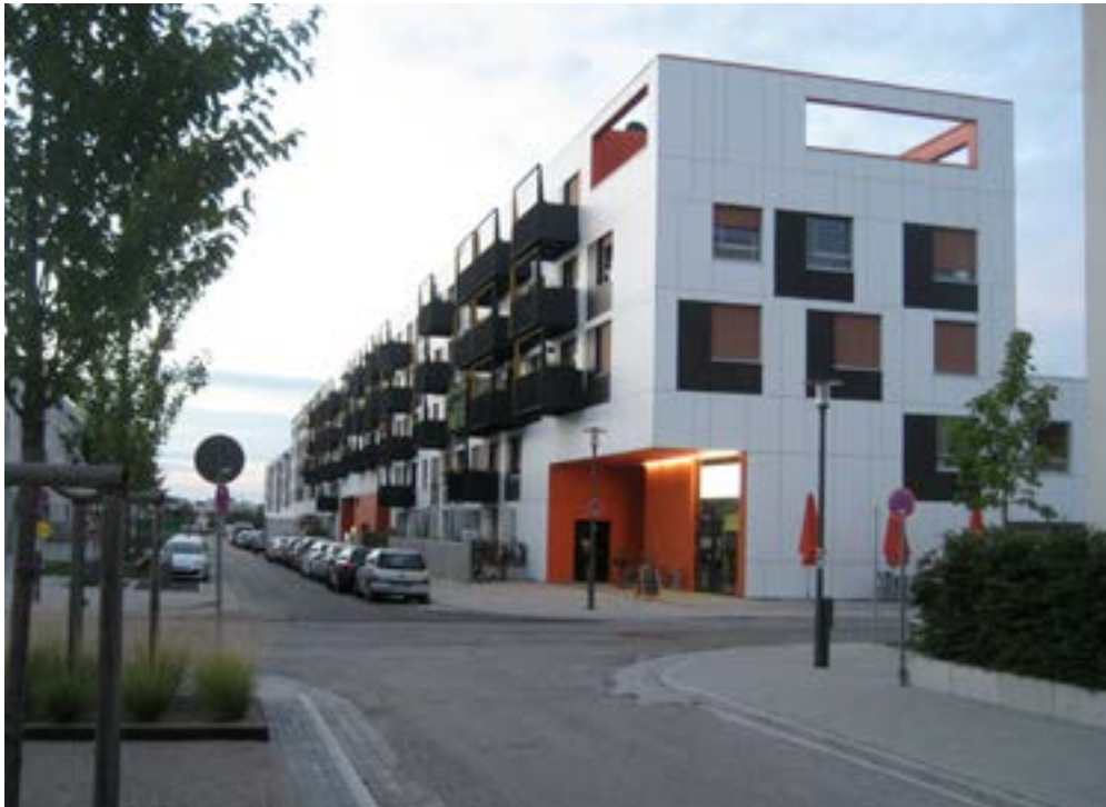
Foto: EM Blick von Süden auf das Mehrfamilienhaus Wagnis 3
