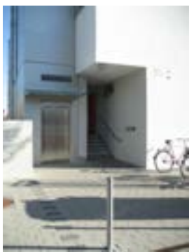
Foto: EM Zugang Treppe / Aufzug
