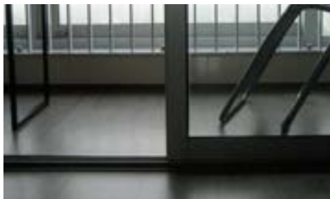
Zugang Loggia (Ansicht)
