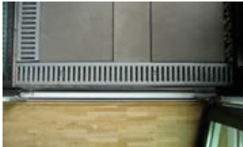
Zugang auf die Loggia (Aufsicht)
