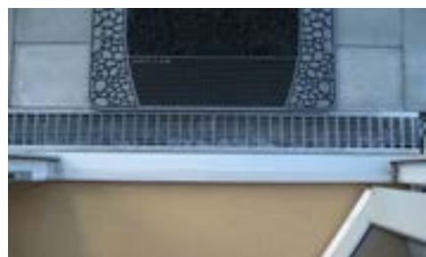
Zugang Dachwohnung (Aufsicht) Foto: EM
