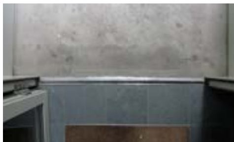
Hauseingang mit Halbrundschwelle (Aufsicht) Foto: EM
