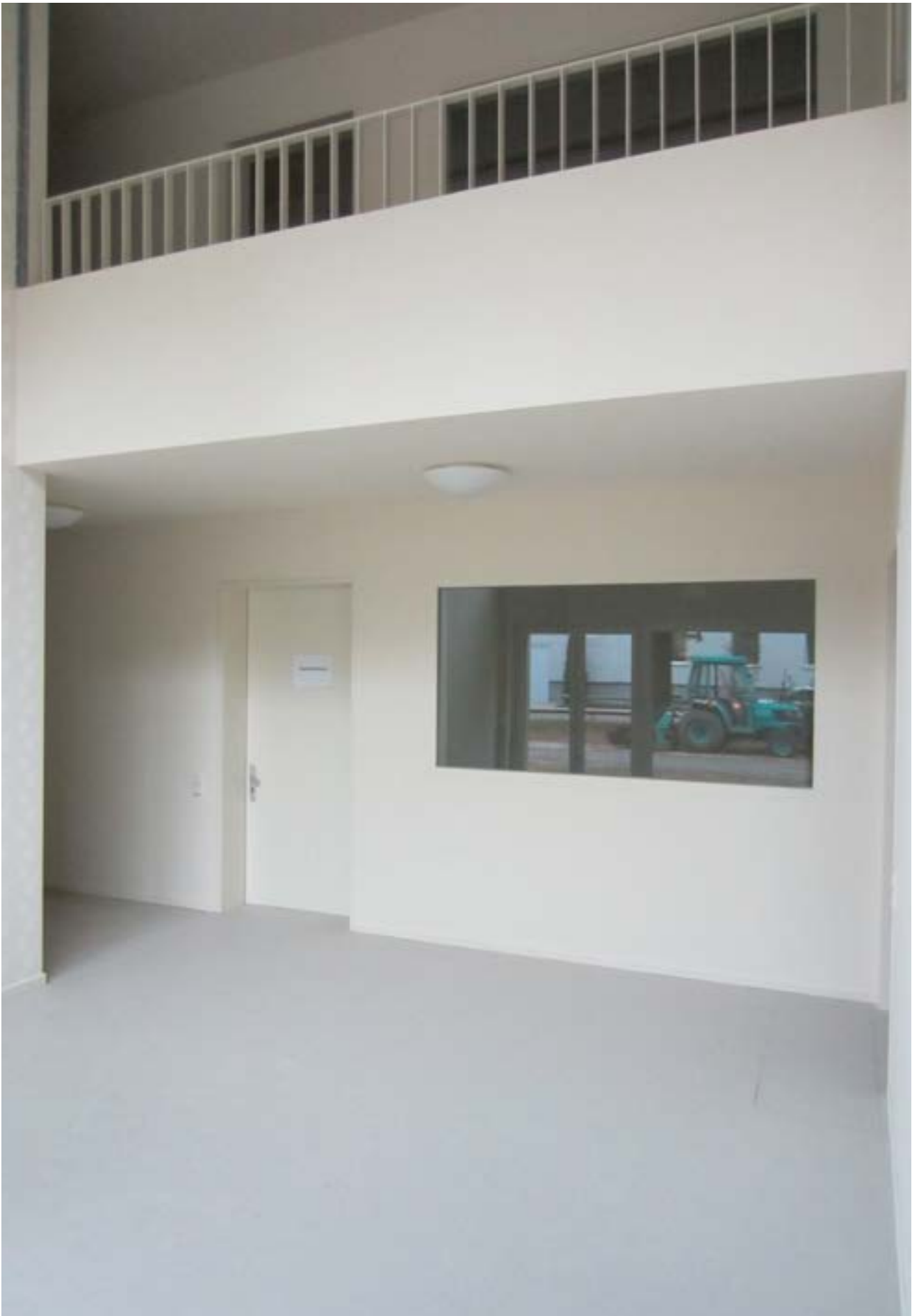
Innengang im 3. OG während der Bauphase mit Galerie zur Halle und sichtbarer Konstruktion für den Brandschutzvorhang (1. Fluchtweg)
