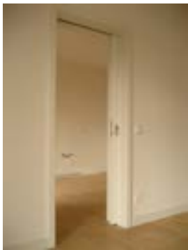
Foto: EM schwellenloser Übergang / Schiebetür
