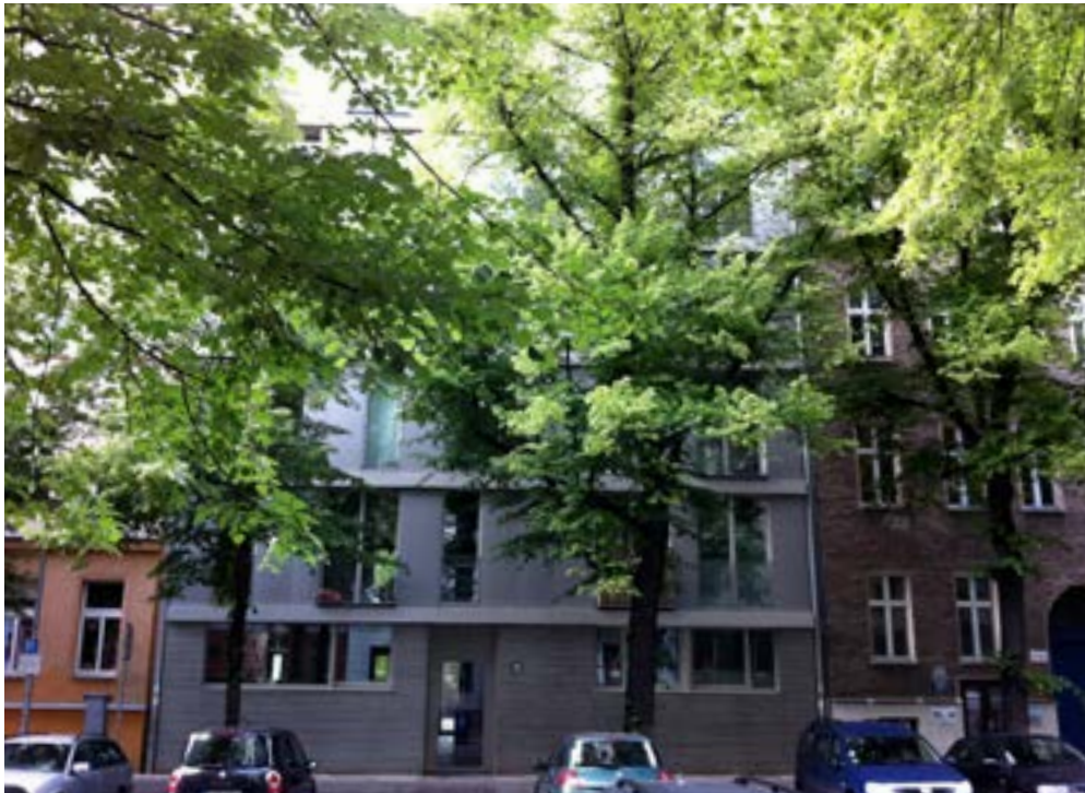
Foto: EM, Blick von Südosten auf die Fassade des Mehrfamilienhauses A 52
