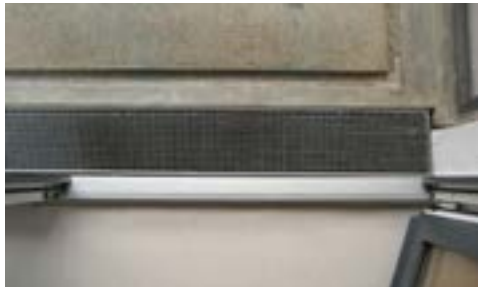
Zugang Loggia (Aufsicht)
