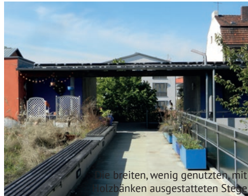
Laubengang, der nur teilweise als Balkonerersatz funktioniert
