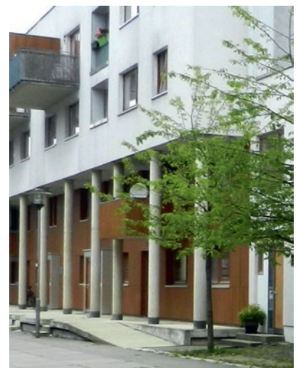
Konstruktiv geschützte Eingangssituation und Holzfassade in den unteren beiden Geschossen in der Kasseler Unterneustadt
