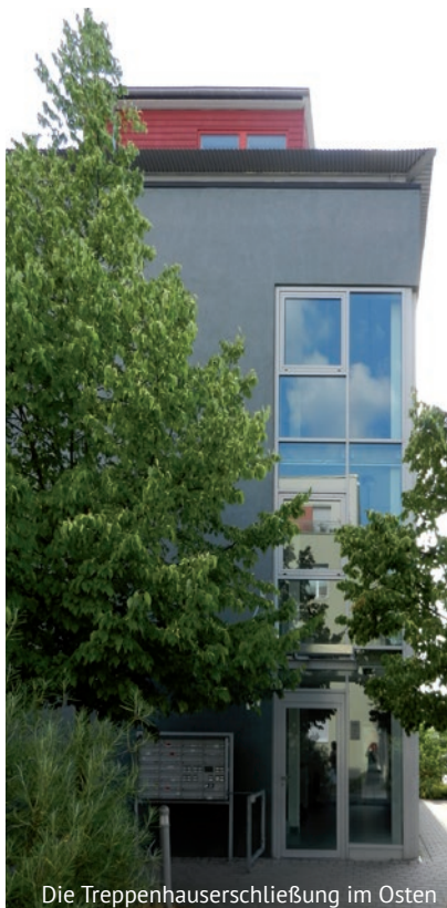
Die Treppenhauserschließung im Osten
