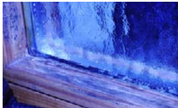
Abb. 88 Schimmelbefall im Bad: Wachstum auf Fliesenfugen und auf dem Holzfensterrahmen (Fotos: Licha/Wallner/Ziegler)
