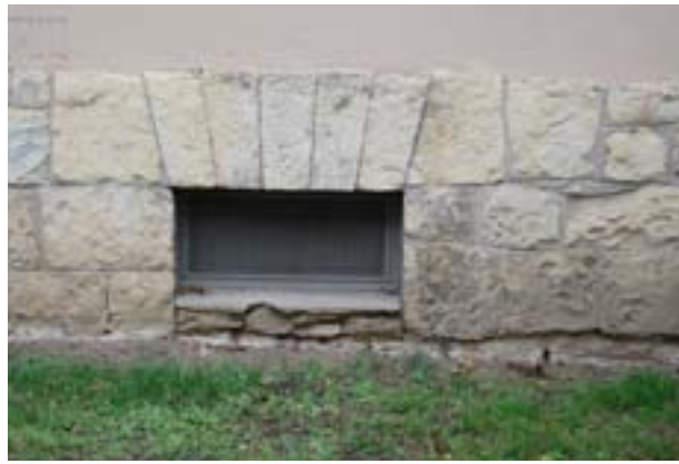
Abb. 81 Intakte Sockelmauer im Bereich von Grünflächen und Kiesschüttung (Fotos: Semmler/Cemodanov)
