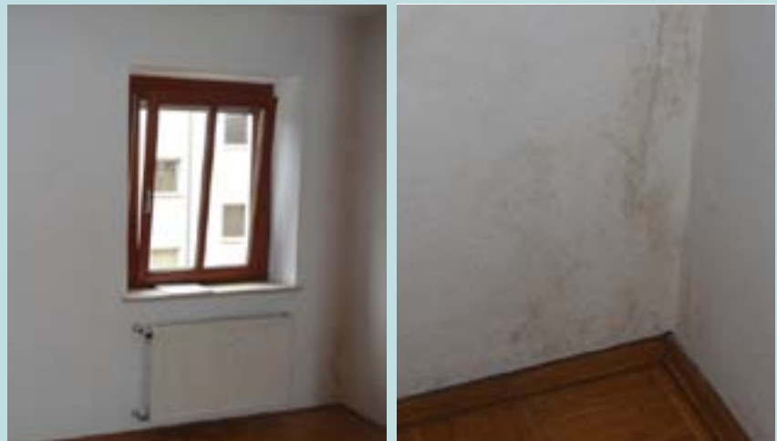
a) Innenseitiger Schimmelbefall an der Schlafzimmereußenwand mit Nordost-Ausrichtung in der Ecke zum Nachbarhaus
