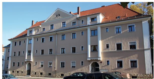
Abb. 4 Nordwestfassade der Fünfhäusergruppe, Walderdorffstraße 15 und 17 (Foto: Zeitler)
