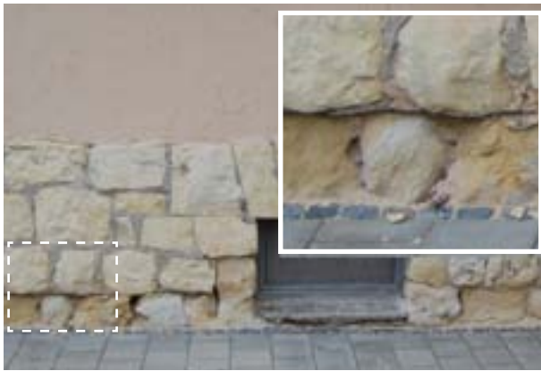
Abb. 85 Horizontalsperre gegen aufsteigende Mauerwerksfeuchte (Foto: Semmler/Cemodanov)
