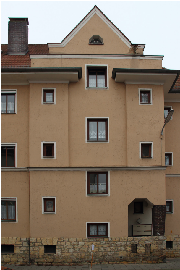
Abb. 6 Nordostfassade der Fünfhäusergruppe, Walderdorffstraße 2, 4, 4a; (Fotos: Zeitler)
