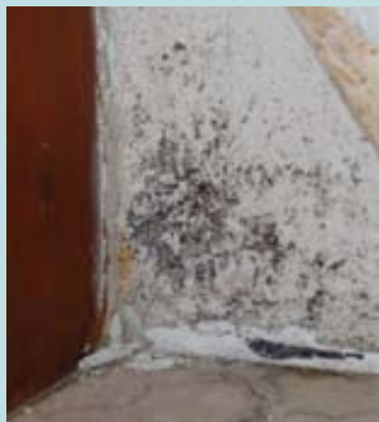
b) Innenansicht der südwestlichen Wohnzimmereußenwand mit Schimmelbefall an vielen Stellen
