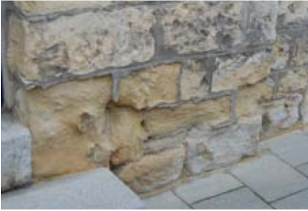
Abb. 83 Schäden am Sandsteinsockel im Bereich von Hauseingängen, Treppen und Gehwegen (Fotos: Semmler/Cemodanov)
