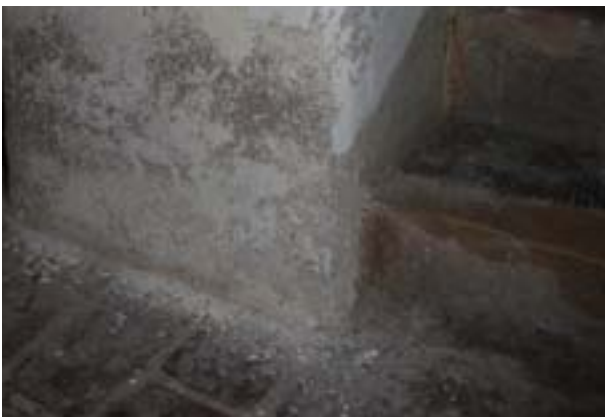
Abb. 91 Oben: Feuchteschäden im Keller an der Nordost-Seite des Plato-Wild-Ensembles. Massive Durchfeuchtung hat zu schweren Putzschäden und mehligem innenseitiger Mauer- schale vor der Natursteinaußenschale geführt. Unten links: Schäden an Putz und Farbanstrich durch aufsteigende Bodenfeuchte im Keller. Unten rechts: Salzablagerungen und Verkalkung durch aufsteigende Bodenfeuchte auf dem geziegelten Kellerboden. (Fotos: Steffens)
