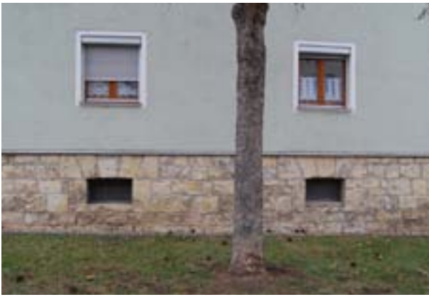
Abb. 81 Intakte Sockelmauer im Bereich von Grünflächen und Kiesschüttung (Fotos: Semmler/Cemodanov)
