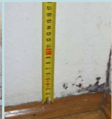
b) Innenansicht der südwestlichen Wohnzimmereußenwand mit Schimmelbefall an vielen Stellen
