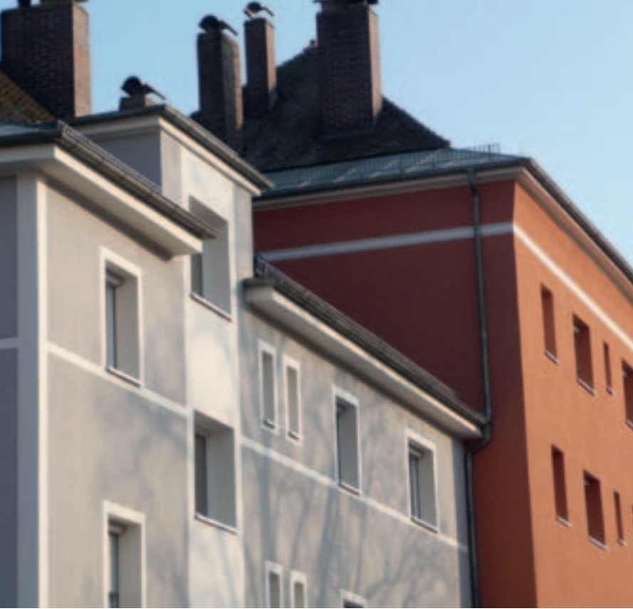
Abb. 72 Wärmedämmverbundsysteme zerstören wesentliche Elemente der historischen Fassadengestaltung und führen zu einer Verzerrung der Proportionen (Fotos: Steffens)
