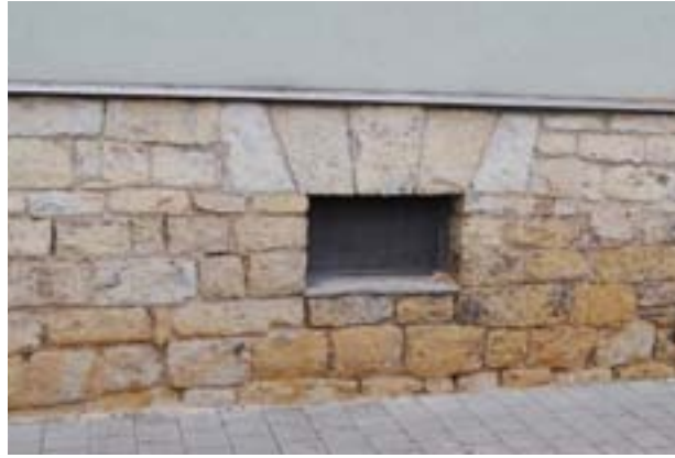
Abb. 83 Schäden am Sandsteinsockel im Bereich von Hauseingängen, Treppen und Gehwegen (Fotos: Semmler/Cemodanov)
